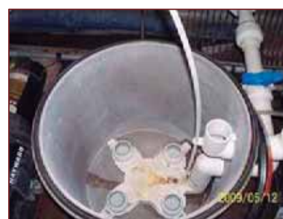
Imagen: Filtro de cartuchos conectado hacia la motobomba, en la imagen derecha se observa el filtro abierto sin cartuchos
