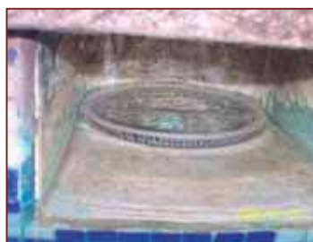
Fotografías: los desnatadores tienen una canastilla de plástico para remover la basura la tapa sobre el piso se quita para limpiar la canastilla
