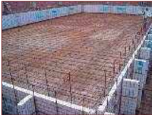
Imagen: armado monolítico de la estructura de la alberca
