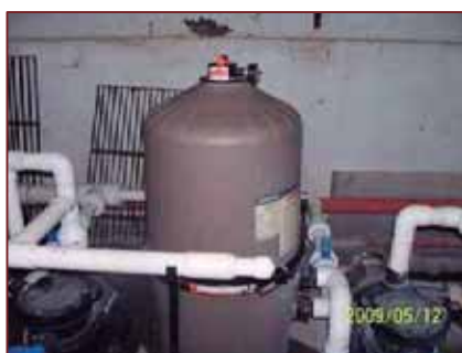
Imagen: Filtro de cartuchos conectado hacia la motobomba, en la imagen derecha se observa el filtro abierto sin cartuchos
