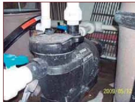
Imagen: se muestra una de las bombas de 2 1/2hp y las conexiones de pvc que dirigen el agua a los filtros.
