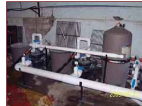
Imagen: se muestra una de las bombas de 2 1/2hp y las conexiones de pvc que dirigen el agua a los filtros.
