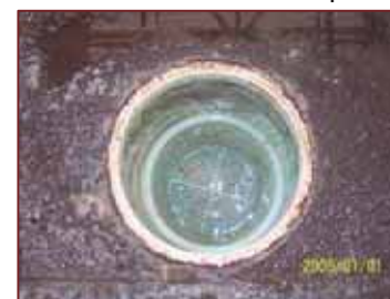
Fotografías: los desnatadores tienen una canastilla de plástico para remover la basura la tapa sobre el piso se quita para limpiar la canastilla
