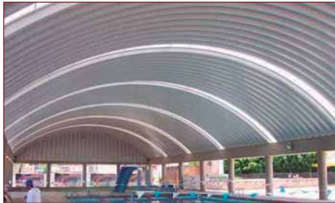
Foto: cubierta de arcotecho cecufid Morelia
