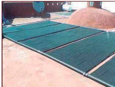
Imagen: paneles solares instalados en la parte superior de un edificio.
