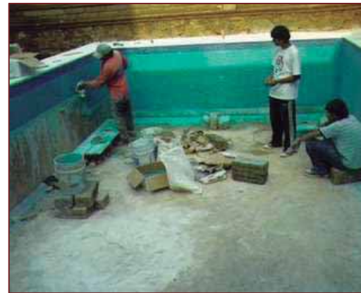
Imagen: colocación de l impermeabilizante a las paredes de la alberca
