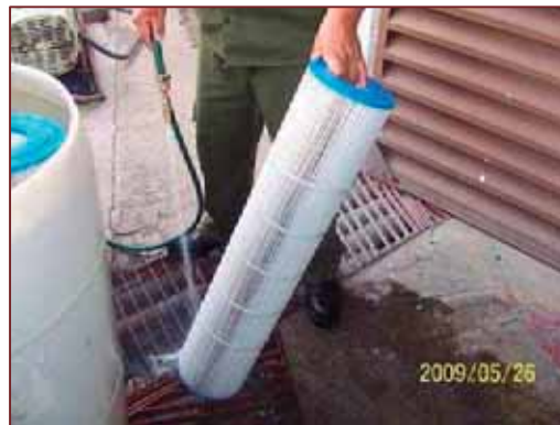
Imagen: cartuchos del filtro en proceso de lavado y sumergidos en flik.
