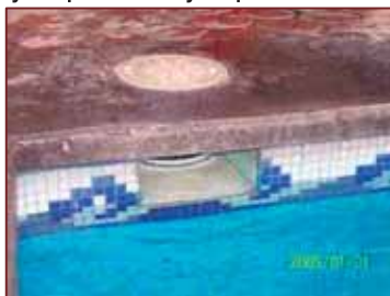
Fotografías: los desnatadores tienen una canastilla de plástico para remover la basura la tapa sobre el piso se quita para limpiar la canastilla
