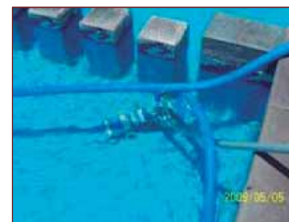
Imagen: se observa el dren de fondo de la alberca.
