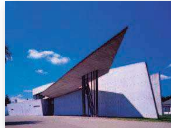
Fig. 27 Estación de bomberos Vitra, proporcionada por arquimaster.com Marzo 2009
