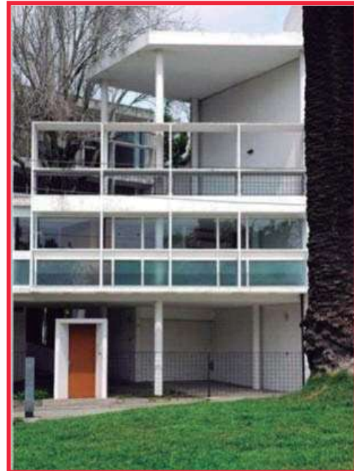
Figura 43. Casa construida por Le Corbusier, en la Plata, Buenos Aires. Origen: www.arquitectura-urbana.com
