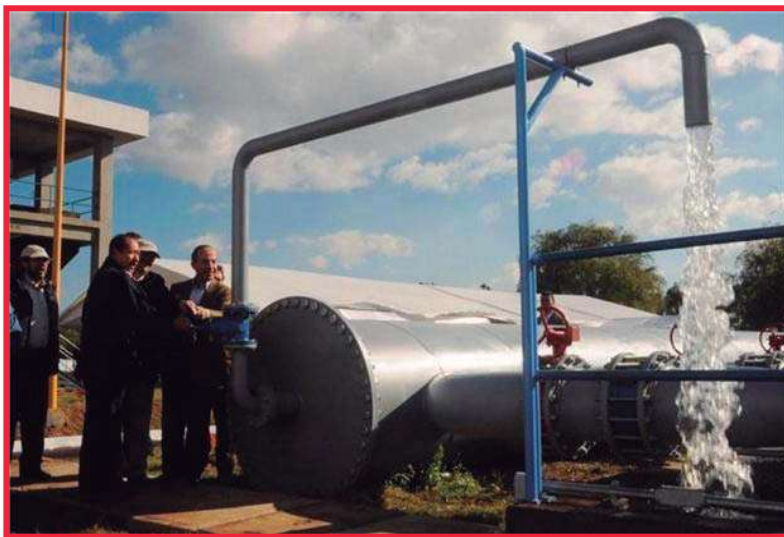
Figura 94. Inauguración de la Planta Potabilizadora de la Minzita. Origen: www.gentedelbalsas.com.mx
