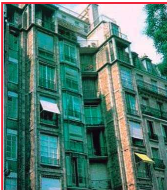
Figura 40. Edificio Rue Franklin en París, de Auguste Perret 1904. Origen: www.kalipedia.com
