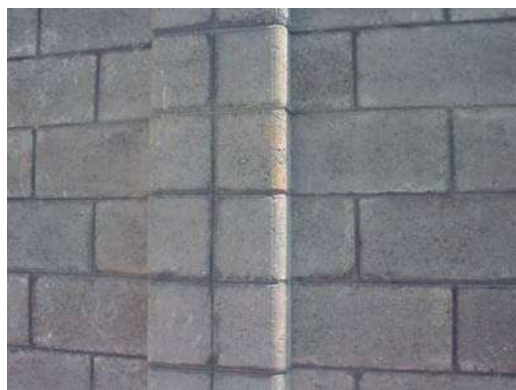
IMAGEN.- Muro perimetral de block.
