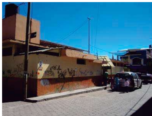
FOTO 4.- Vista posterior, baños públicos del mercado actual. (Fachada oeste).
