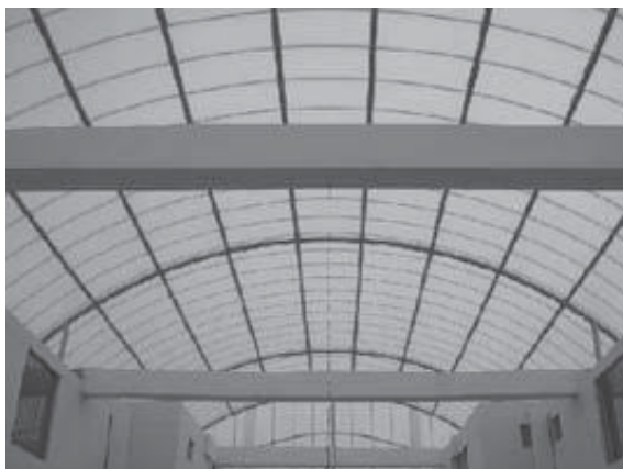
IMAGEN.- Cubierta domo.
