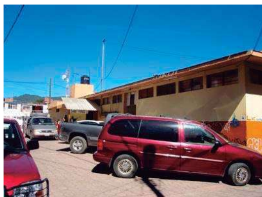
FOTO 3.- Vista posterior, del terreno, (Fachada oeste del mercado, modulo 1).
