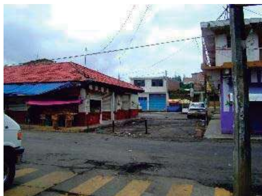
FOTO 9.- Vista principal, del terreno. (Fachada este del mercado, modulo 2)
