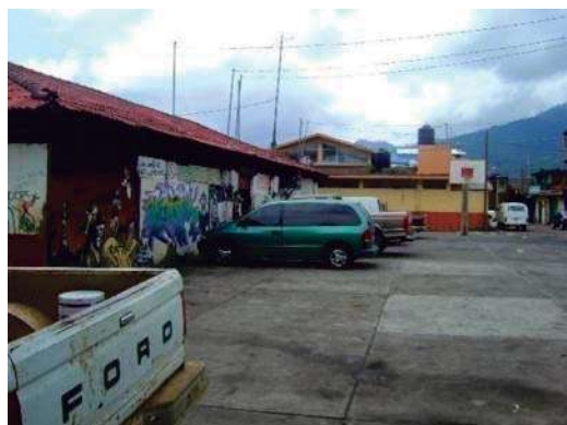
FOTO 7.- Vista posterior del terreno, (Fachada oeste del mercado actual, modulo 2).
