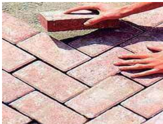
IMAGEN.- Colocación de adoquín.
