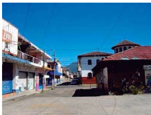
FOTO 8.- Vista calle lateral del terreno (Fachada norte del mercado actual).
