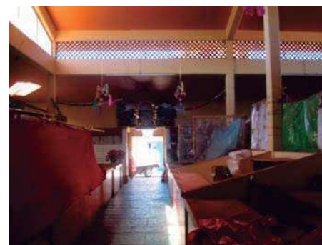
Foto.- locales sin uso (modulo 1).
