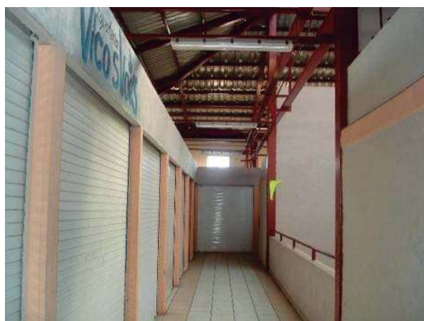
Foto 5.- Locales en el 2º nivel (en la actualidad aun no se encuentran en uso).
