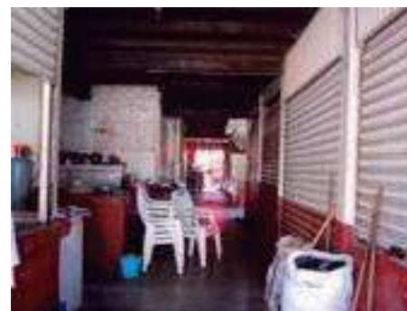
Foto.- locales sin uso (modulo 2).
