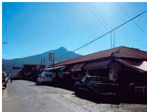
FOTO 10.- vista lateral, (fachada norte del mercado actual, modulo 2).
