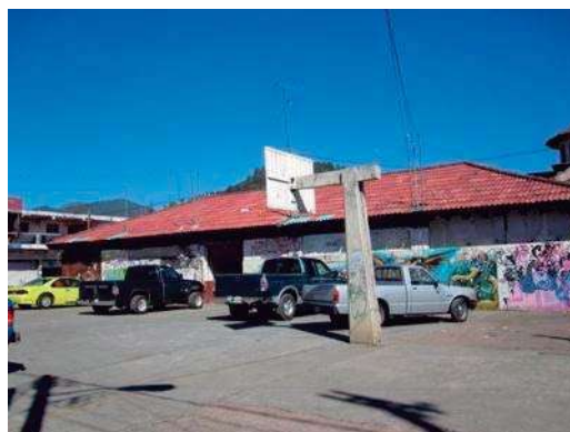
FOTO 6.- vista posterior del terreno. (Fachada oeste del modulo 2, del mercado actual).
