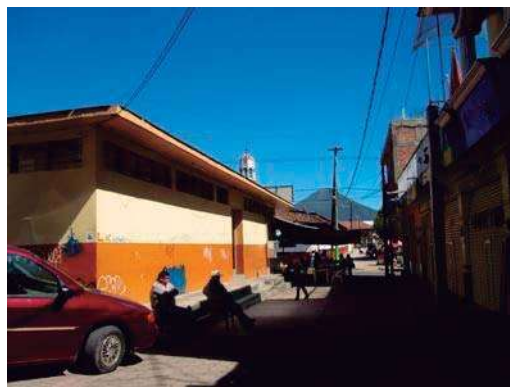
FOTO 2.- Vista posterior, del terreno, (Fachada sur del mercado, modulo 1).
