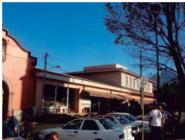
Foto 1.- Fachada principal del mercado, construido en dos niveles.
