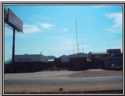
IMAGEN F3: CPO (2009). Vista desde la carretera salida a Churumuco-Apatzingan
