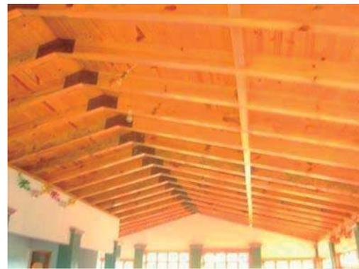
Imagen V.20 (foto 6). La cubierta está sostenida por un sistema de viguería de madera dispuestas a cada 50 cm. una con respecto a otra, unidad por dos placas de metal con 8 pernos de presión.
