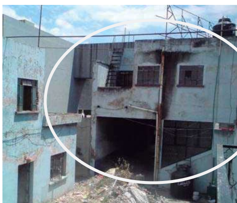
FOTO 44. Lado Sur de proyecto de Ings. Rodríguez S. Fotografía tomada por los autores.
