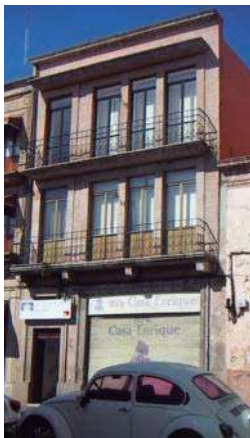
FOTO 60. Fachada actual Casa Enrique. Fotografía tomada por los autores.
