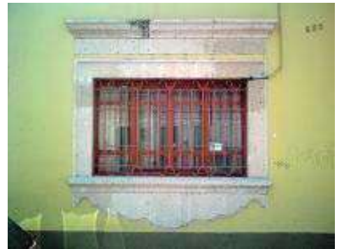
FOTO 71. Ventana del edificio ubicado en la esq. de Antonio Alzate y Sánchez de Tagle. Ings. Rodríguez Soto. Fotografía tomada por los autores.
