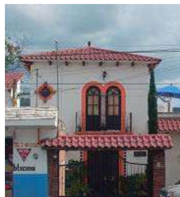
FOTO 13. Casa ubicada en la antigua Colonia "California" (al oriente del centro histórico) considerada estilo californiano. Fotografía tomada por los autores.
