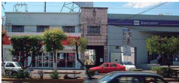
FOTO 40. Aspecto actual de Edificio Amelia. Fotografía tomada por los autores.
