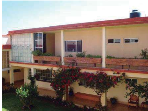
FOTO 92. Primer patio interior del "Claretiano. Ings. Rodríguez Soto
