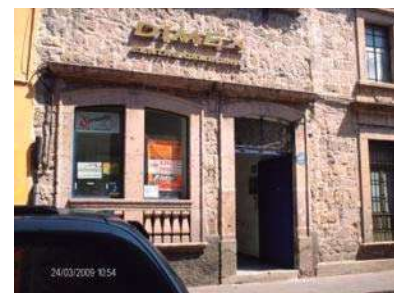
FOTO 54. Aspecto actual del edificio en Ocampo, marcado con el número 46. Fotografía tomada por los autores.
