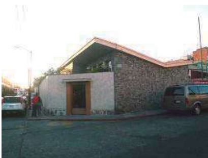
FOTO 34. Cubierta “techo mariposa”. Isidro Huarte #42. Fotografía de los autores.
