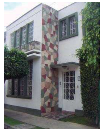
FOTO 97. Fachada de la casa en General Ampudia #32. Ings. Rodríguez Soto
