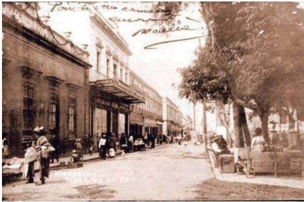
FOTO 16. Calle Valladolid. Vista poniente
