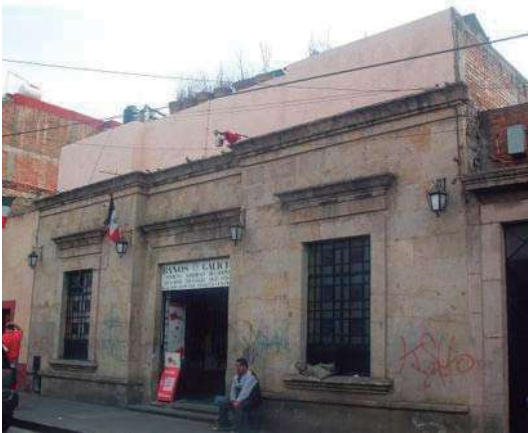
FOTO 56. Fachada actual de Baños Galicia. Fotografía tomada por los autores.
