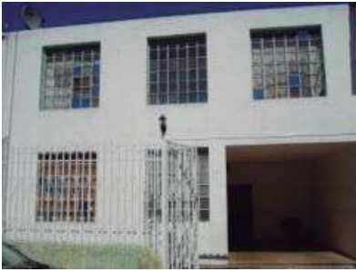
FOTO 45. Fachada de una vivienda orientada al norte.
