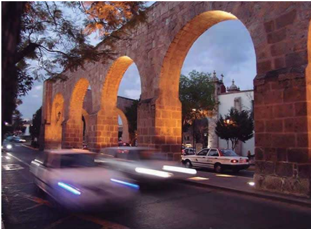
FIGURA 49. Acueducto de Morelia en su situación actual.
