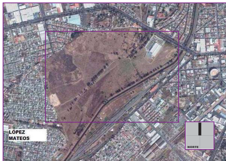
FIGURA 63. Vista satelital del terreno B.
