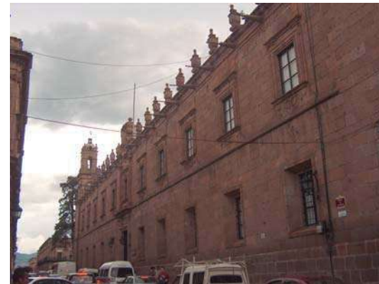
FIGURA 44. Fachada principal, calle Nigromante, Morelia Mich.
