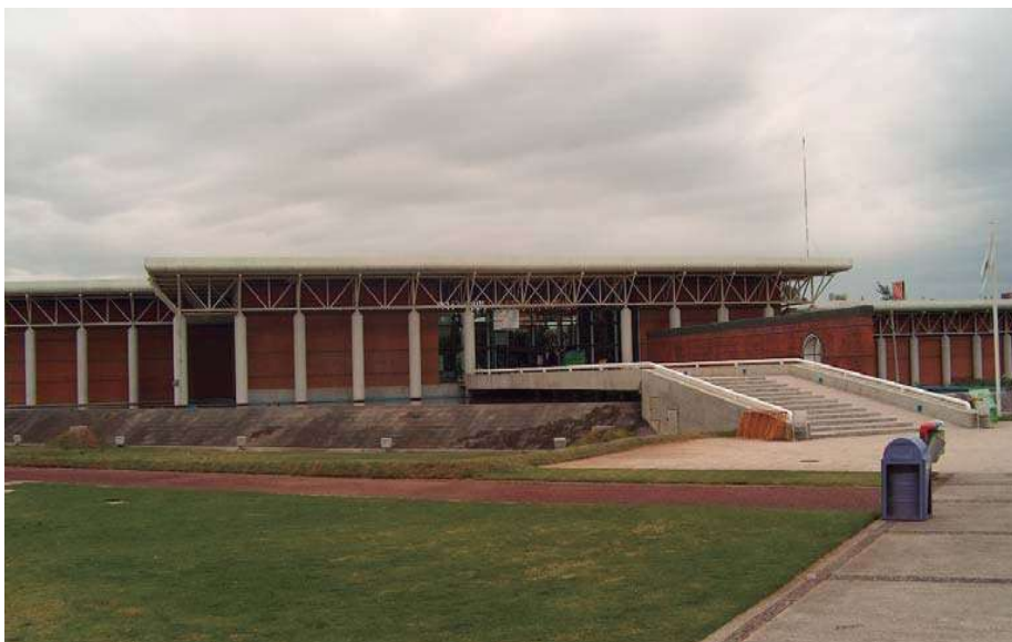
FIGURA 19. Fachada principal del Centro Interactivo de Ciencias Explora, León Guanajuato.
