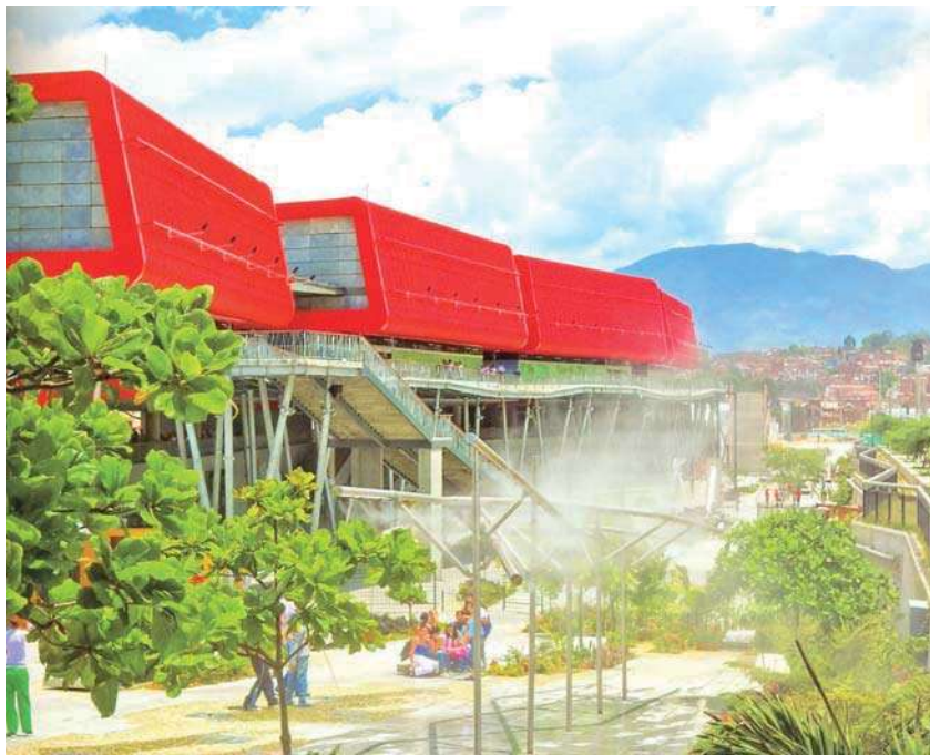
FIGURA 12. Vista de la plaza, Parque Explora, Medellín Colombia.
