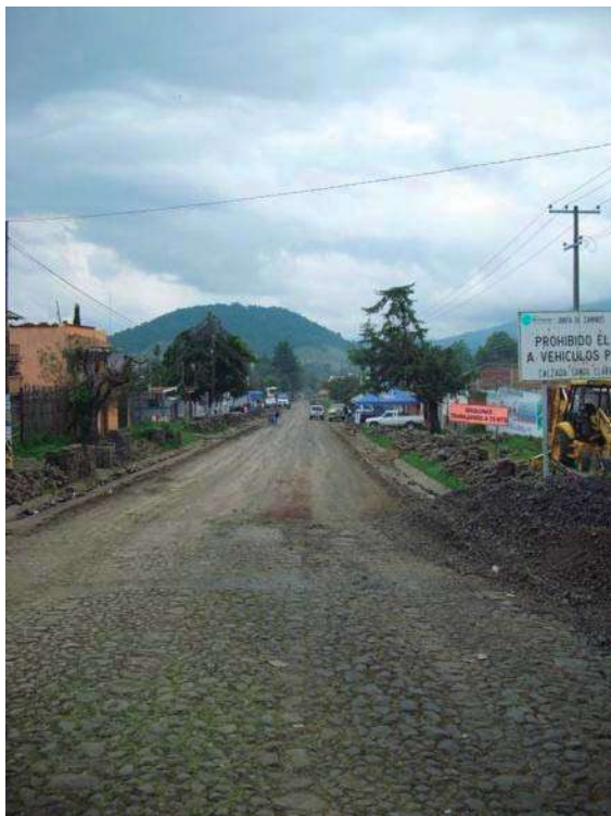
Fotografía 49 Calzada a Zirahuén. Autor. Ernesto Miranda Domínguez
