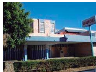
Imagen 19: Fuente: Autor. Entrada a urgencias de la clínica del ISSSTE, en Morelia.
