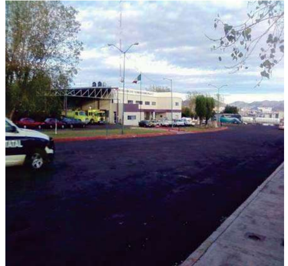
ESTACIÓN MUNICIPAL DE BOMBEROS
