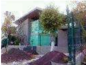
EDIFICIO ALMACEN DE LA DIRECCIÓN DE TRANSITO
