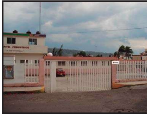
Fig. 23.- Exterior del Hospital.
