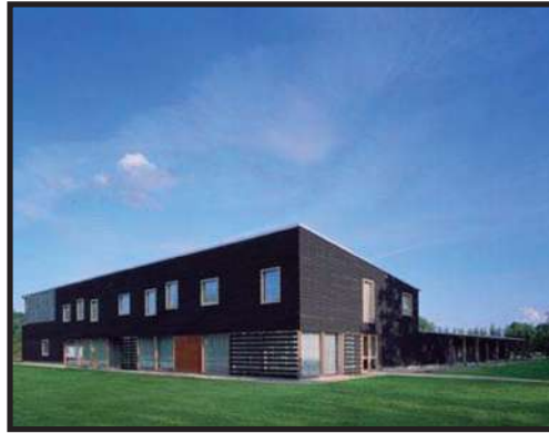
Fig. 14.- Exterior del hospital.
