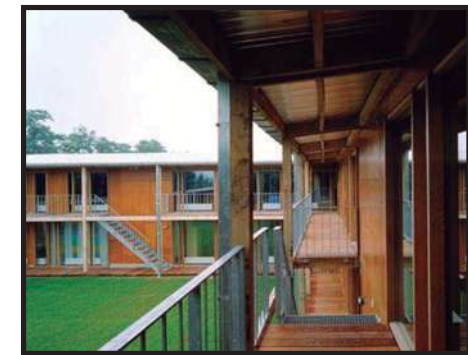
Fig. 16.- Pasillo externo en planta alta.
