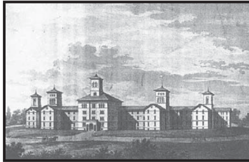
Fig. 3.- Exterior del hospital
