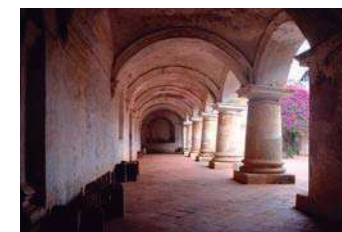
Fig. 16. Construcción española. Foto A. Montaña.
