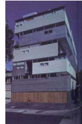
Fig. 40. Fachada principal. Foto de: Oscar Necochea.
