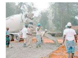
Fig. 73. Vaciado de concreto premezclado. Fotografía de: J. Julio Chávez Hernández.
