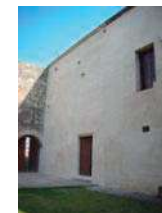
Fig. 62. Aplanado de cal en muros. Restauración ex convento de Tzintzuntzan. Imagen: Arq. Alejandro Vega Marín.
