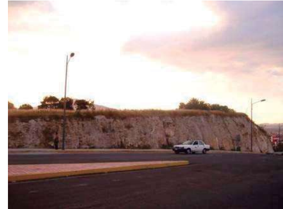
Figura 27.- Vista desde la Avenida Guadalupe Victoria.
