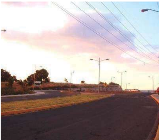
Figura 22.- Vialidad primaria Avenida Guadalupe Victoria mayor tránsito de transporte público
