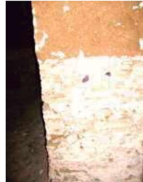
Fig. 103. Detalle del muro del salón de catecismo, se aprecia el sistema de rajueado a 1 m. de alto. Fuente: Holguín Ramón, diciembre 2009.
