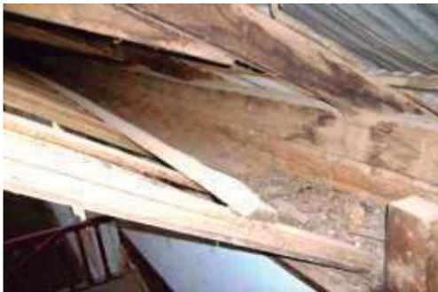
Fig. 112 Apoyo de la armadura de cubierta en el arrastre. Fuente: Holguín Ramón, diciembre 2009.
