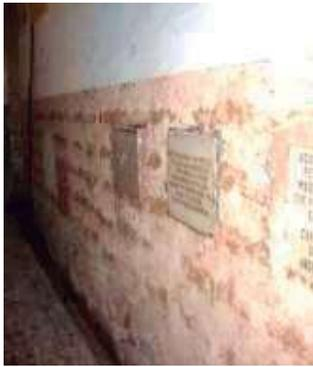
Fig. 101 Muro norte de la nave principal, se aprecia el sistema de rajueado en las juntas. Holguín Ramón, diciembre 2009.
