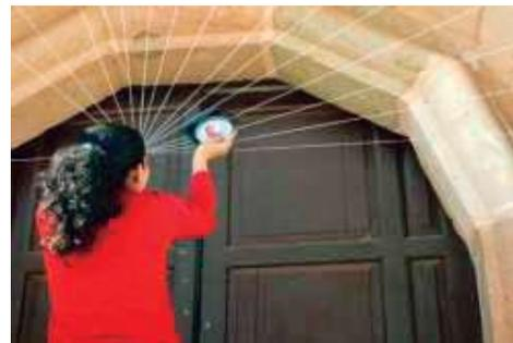
Fig. 28. Obtención del dovelamiento del cerramiento curvo del acceso principal. Fuente: Holguín Ramón, diciembre 2009.
