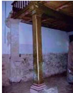
Fig. 108 Pilastra de madera, pilastra de cantería y viga principal del coro. Fuente: Holguín Ramón, diciembre 2009.
