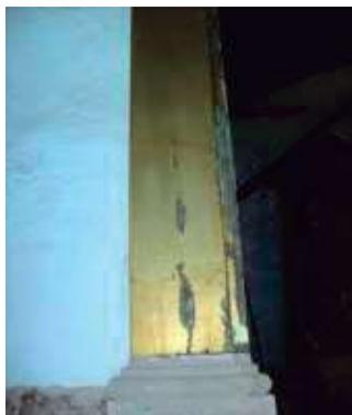
Fig. 110 Pilastra de transepto con dintel de madera, resaltan los jabalones que apoyan el cerramiento y el pedestal de cantería. Fuente: Holguín Ramón, diciembre 2009.
