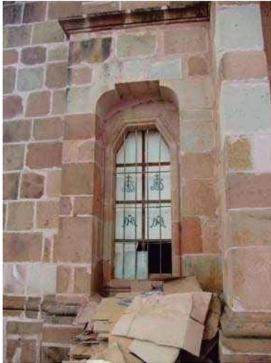
Fig. 105 Muro del frontispicio donde se aprecia la disposición de la sillería. Fuente: Holguín Ramón, diciembre 2009.
