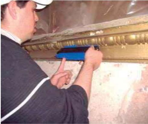
Fig. 37. Obtención de las molduras con el peine.
