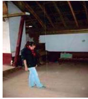
Fig. 31 Obtención de la geometría de la bóveda corcha de la nave principal. Fuente: Holguín Ramón, diciembre 2009.
