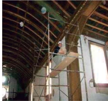
Fig. 38. Obtención de detalles de jabalcones y vigas de crucero.
