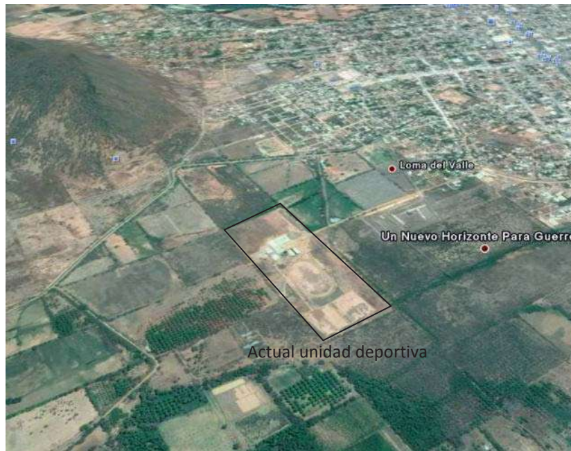
Fig.5 Vista aérea de la Unidad Deportiva
