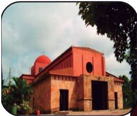
Imagen N° 16 Exterior de la Nueva iglesia de Santiago Acahuato
