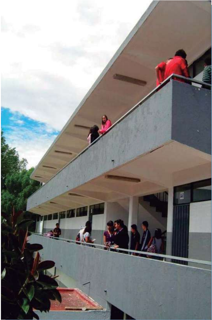
← Imagen 37 - Las aulas se encuentran ubicadas de forma lineal, conectadas por medio de un pasillo, el primer edificio tiene tres pisos y barandal de concreto.
