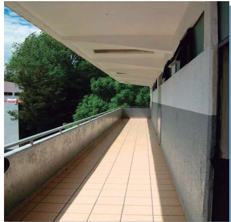
Imagen 36 - Los pasillos se encuentran cubiertos, tienen una anchura de 1.50 mts. Con piso antiderrapante, el pretil es de concreto con barandal de metal. →
