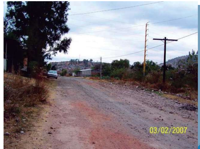
IMAGEN 53 - Vista de sur a norte de la calle "de insurgentes", en donde se encontraría Ubicado el acceso principal de la preparatoria.
