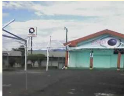
Img.1.- Condición actual del recinto.
