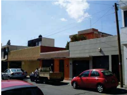
Ilustración 72 Casas Martorel, Mier y Carillo. Estado actual. Foto G.I. R.C.
