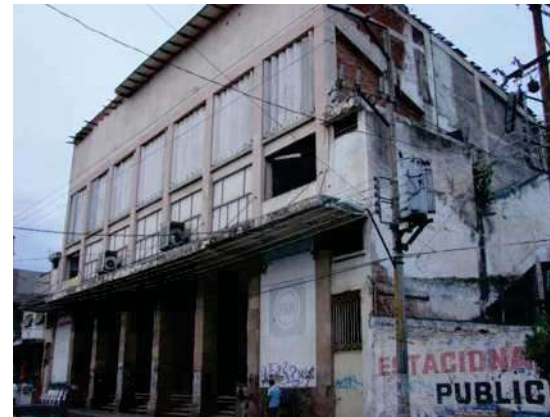
Ilustración 52 Actualmente el edificio se encuentra en desuso. Foto. J. Álvarez
