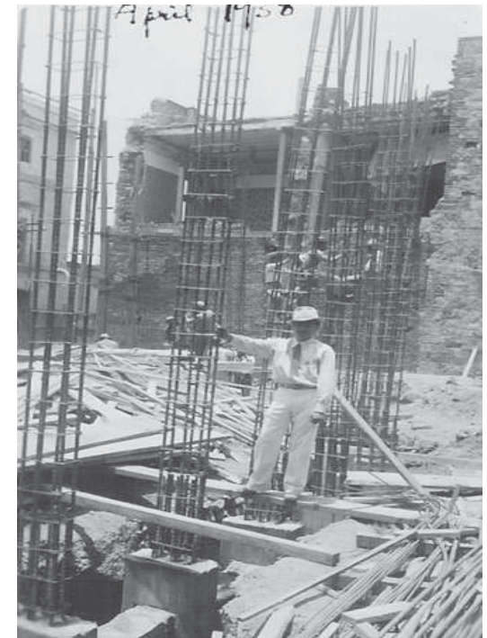
Ilustración 7 Ing. Jaime A Sandoval como residente de obra Hotel Alameda. Abril de 1938 (Archivo Fam. Sandoval)
