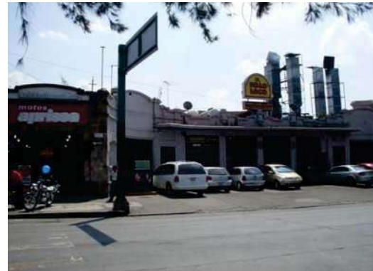
Ilustración 71 "El Pollo Loco" Lugar donde fue construido el Garage Martínez. La remodelación estuvo a cargo de los hermanos Rodríguez Soto. Foto G.I.R.C.
