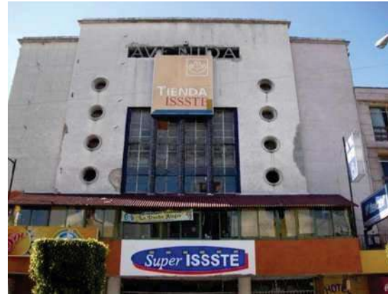
Ilustración 46 el edificio actualmente es ocupado como tienda del ISSSTE. Se aprecia una estructura adosada a la fachada.
