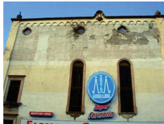
Ilustración 53 Detalles de la fachada principal
