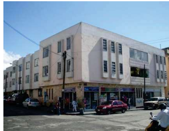
Ilustración 29 Fachada de la Clínica Hospital de Fátima. Proyecto arquitectónico Arq. Martha Sandoval, la obra fue dirigida por el Ing. Jaime A Sandoval y su hijo el Ing. Jaime F Sandoval W. Foto. G.I.R.C.
