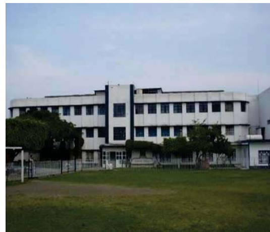
Ilustración 55 Vista de la Fachada posterior. Foto G.I.R.C.
