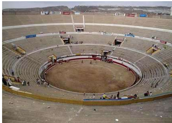
Ilustración 66 Vista Interior Plaza de Toros Las Palmas
