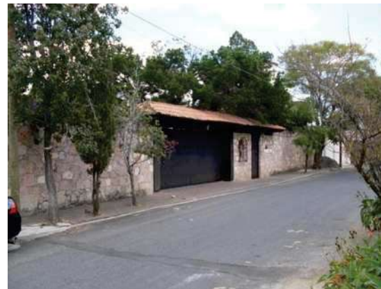
Ilustración 78 Casa del Dr. Lozano se levanto barda perimetral al frente de la fachada, la casa ha tenido no ha tenido pocas intervenciones. Foto G.I.R.C.
