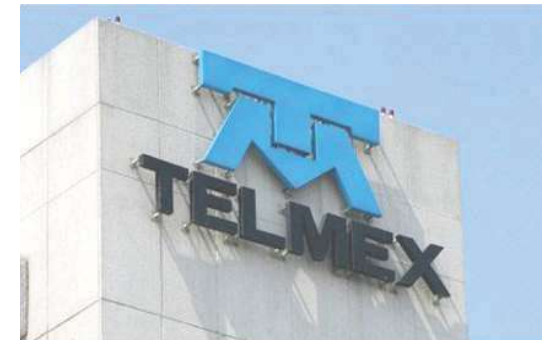
Fig. 37.- Teléfonos de México (TELMEX)
