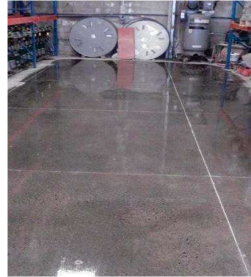
Fig. 58.- Piso de Concreto Pulido
