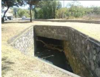
Imagen 141. La zona cuenta con drenaje, alumbrado público, acotamiento, señalización y agua potable.
