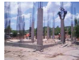
Imagen 145 detalle de columnas de concreto
