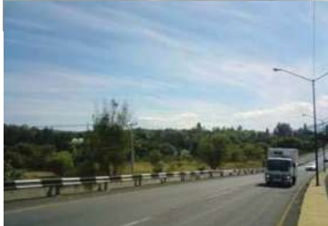
Imagen 138. Vialidades con acotamiento y alumbrado público de 2 carriles en ambos sentidos.
