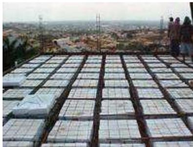
Son losas las cuales se hacen en obra y se caracterizan porque de abajo se ven muchos cuadrados de concreto los cuales tiene esa forma por que los hacen con módulos cuadrados que hacen de molde el cual es prefabricado.
