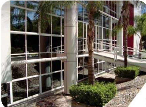
IMAGEN. 2.- INTERIOR Y EXTERIOR DEL (DICI) ITESM, CAMPUS QUERÉTARO, EN LAS SIGUIENTES FOTOS SE PUEDEN APRECIAR ALGUNOS TALLERES DE LA ESCUELA DE DISEÑO INDUSTRIAL ASÍ COMO LAS FACHADAS. FOTO R.B.J.
