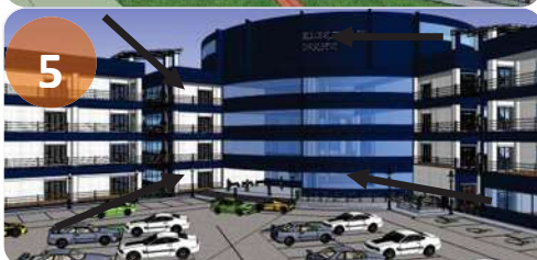
IMAGEN 81.- EN LAS SIGUIENTES IMÁGENES SE MUESTRA LA APLICACIÓN DE VIDRIO DOBLE, ALUCOBOND Y PARASOLES, LOS CUALES FUERON UTILIZADOS EN LA PROPUESTA DE LA ESCUELA DE ARQUITECTURA. IMAGEN R.B.J.
