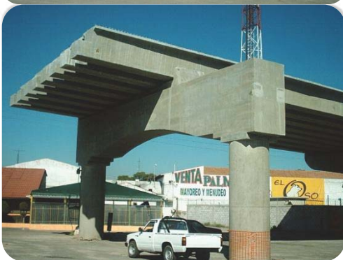
IMAGEN 57.- PUENTE LAS AMÉRICAS 1, EN EL ESTADO DE QUERÉTARO, EN ESTAS FOTOS SE APRECIA LA CONSTRUCCIÓN DE UNO DE LOS PUENTES DE LA CIUDAD, EL CUAL HA SIDO DE GRAN UTILIDAD.
