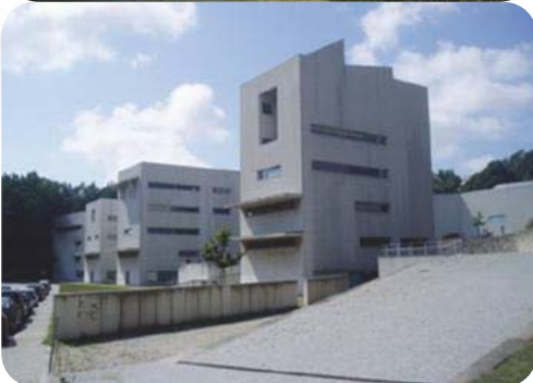
IMAGEN 62.- ESCUELA DE ARQUITECTURA DE OPORTO, DE ALVARO SIZA, LA ESCUELA SE COMPONE DE VARIOS VOLÚMENES, LOS CUALES SE UBICAN DE FORMA ESTRATÉGICA.
