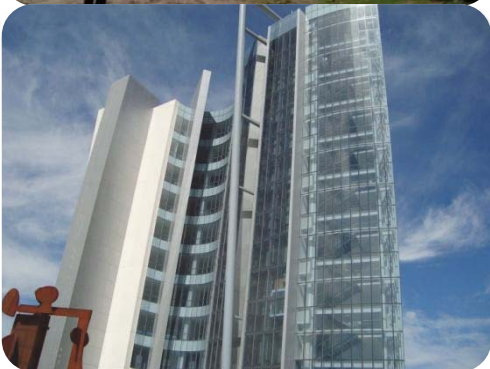
IMAGEN. 20.- PARQUE TECNOLÓGICO CAMPUS QUERÉTARO, EN LAS FOTOS SE MUESTRA LA CONSTRUCCIÓN MAS RECIENTE DEL TEC, CUENTA CON UNA ALTURA APROXIMADA DE 35 A 40 M. LA CUAL SE INAUGURÓ EN MARZO DEL 2010. FOTO R.B.J.
