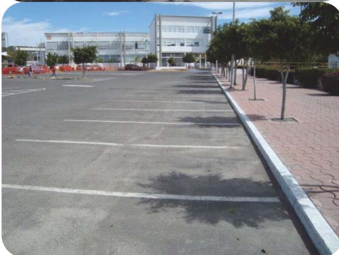
IMAGEN 45.- CENTRO DE FORMACIÓN INTEGRAL, PREPARATORIA Y TERRENO PROPUESTO CAMPUS QUERÉTARO, EN LAS FOTOS SE PUEDEN APRECIAR LAS CONSTRUCCIONES MÁS CERCANAS AL TERRENO PROPUESTO, ASÍ COMO EL CANAL DE AGUAS PLUVIALES FOTO DE R I
