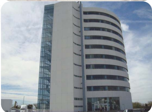
IMAGEN 61.- ESCUELA DE DISEÑO, PREPARATORIA, SALÓN DE CONGRESOS Y EL PARQUE TECNOLÓGICO. EN LAS FOTOS SE PUEDE OBSERVAR EL TIPO DE ARQUITECTURA DEL CAMPUS QUERÉTARO. FOTO R.B.J.
