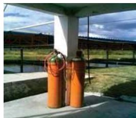
Fig.1.12. Tanques de oxígeno para incubadoras.
