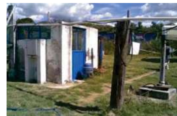
Fig.1.13. Cuarto de máquinas.
