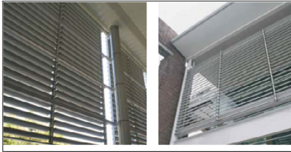
Ilustración 64. Ejemplo del uso de parasoles para bloquear la entrada directa de los rayos solares.
