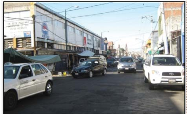
Ilustración 13. Infraestructura y Equipamiento. Infraestructura de Vialidad, Servicios de Telefonía, Electricidad, Sanitarios (Drenajes) e Iluminación. Tomada por Marcelino Cordero albino. Lunes 19 de Abril de 2010; 5:19 pm.
