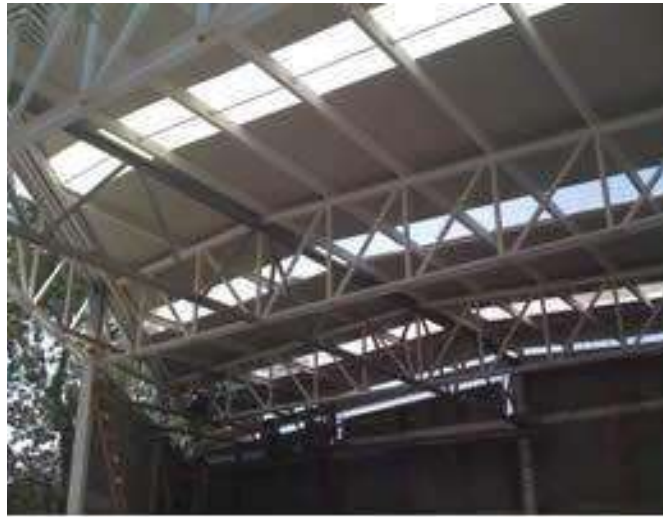
Imagen 41 de cubierta con lamina traslucida 110
