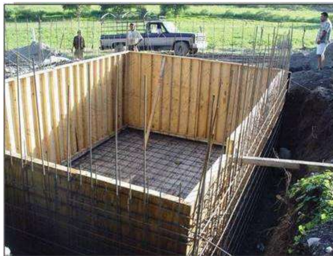
Imagen 56 de cimbra para una cisterna 130
