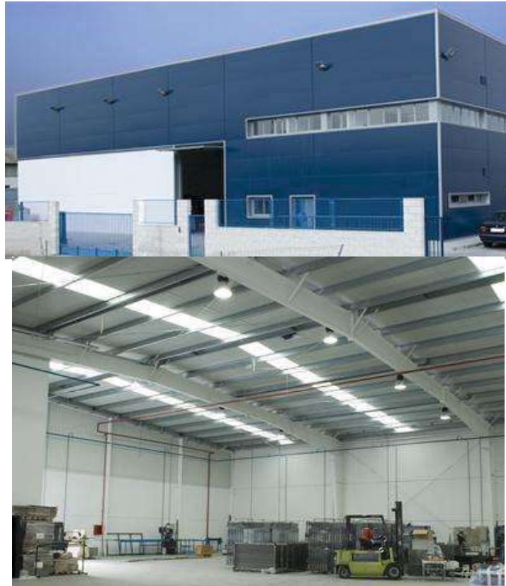
Imagen 04 Fachada y vista interior de la nave industrial de la empresa FERCHAPA. 12
