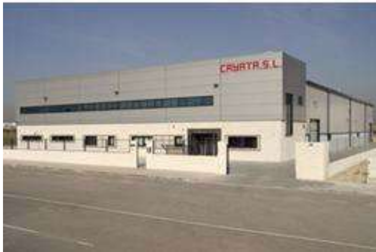
Imagen01 Fachada de la nave industrial de la empresa CAYATA. 7
