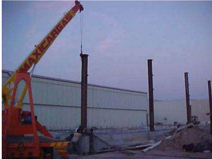
Imagen 37 Fotografía del proceso de colocación de columnas metálicas tipo IR 106
