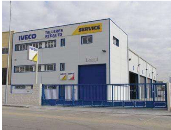
Imagen 02 Fachada principal de la industria IVECO. 9
