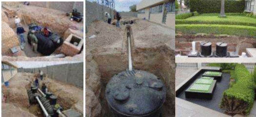
Imagen 62 de instalación del sistema Biodeg 138
