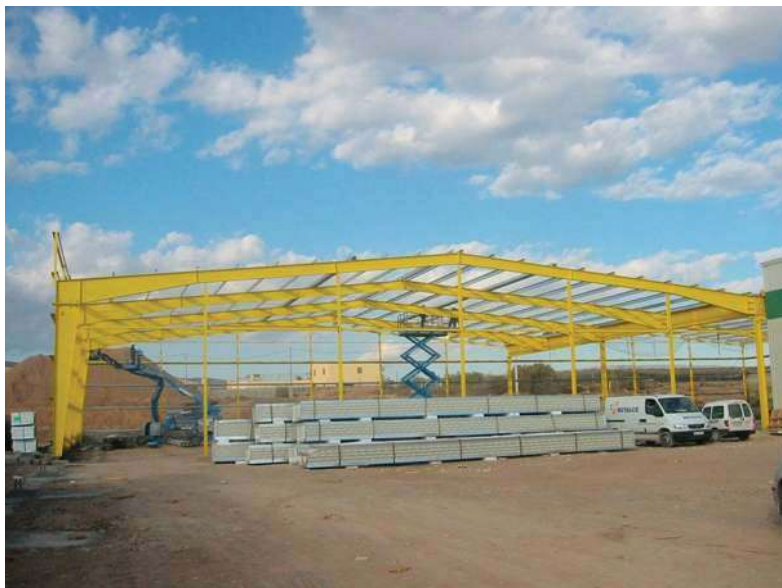
Imagen 36 Esqueleto de una nave industrial de estructura metálica. 104
