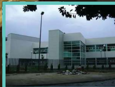
Imagen 20: Fachada UMMA, inaugurado en el 2009.
