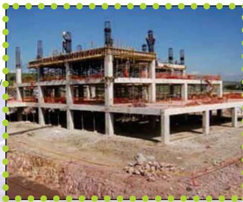
Imagen 24, Construcción del Hospital de altas especialidades del ISSSTE.
