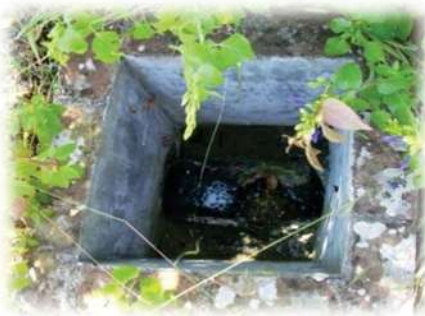
Imagen 3.8 Fotografía del registro de alcantarillado o que se
