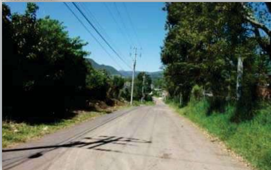
Imagen 3.5 Camino a Corucha, vía arterial y es la vialidad principal de acceso al Terreno, se muestra que se encuentra pavimentada y en buen estado. Fuente: Van-Dan
