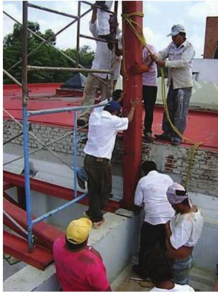
Imagen 37.- montaje y punteado de soldadura.
