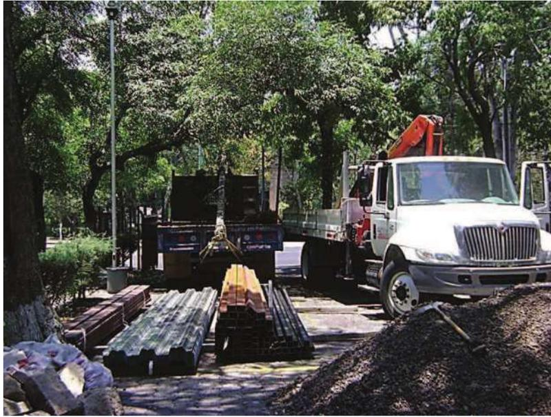
Imagen 17.- Depósito de los perfiles metálicos en patio de maniobras.
