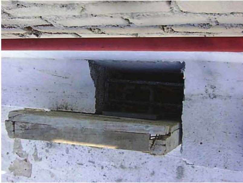
Imagen 18.- cimbrado y colocación de placa para colar castillo.
