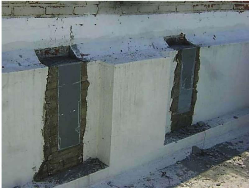
Imagen 19.- Castillo colado y descimbrado con placa base ahogada para fijar armadura.
