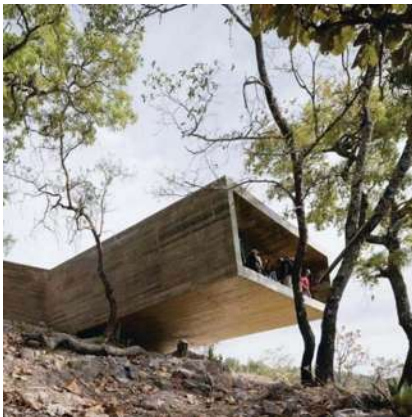
ILUSTRACIÓN 45 MIRADOR LAS CRUCES ELEMENTAL / ALEJANDRO ARAVENA FOTOGRAFÍA: IWAN BAAN ANTENQUILLO, JALISCO
