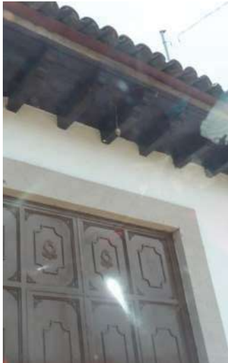
ILUSTRACIÓN 79. SE UTILIZA MADERA EN LA MAYORÍA DE LAS PUERTAS.
