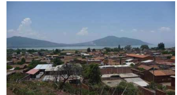
Ilustración 78. La mayoría de las cubiertas son de teja , y algunas casas tienen losa de concreto.
