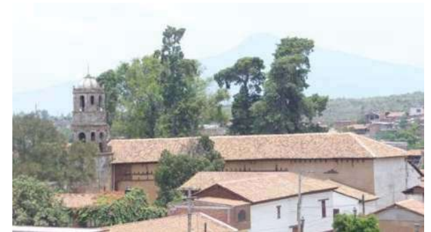
Ilustración 73. Vista de las cubiertas del poblado.
