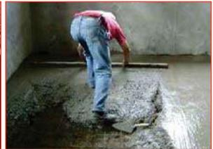
Colado de firme de concreto armado con malla electrosoldada 6x6/10-10 de 10 cm de espesor.
