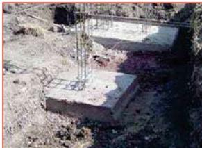
Desplante de zapatas aisladas de 20 cm de espesor
