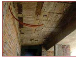
Salidas electricas en losa enmanguerado por muros.
