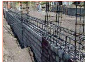
Muro de enrase de 28 cm de espesor
