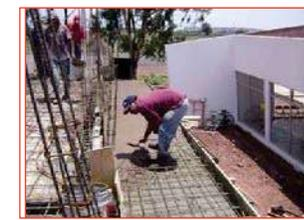
Colado de losa meciza de de 12 cm de espesor de la grapa de acceso
