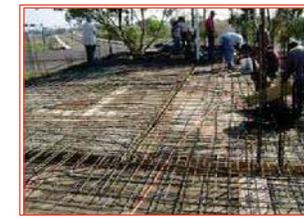
Armado de losa meciza de de 12 cm de espesor
