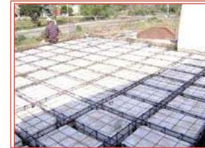
Armado de losa reticular de 25 cm de espesor
