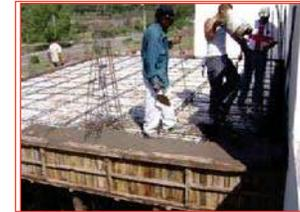
Colado de losa reticular de 25 cm de espesor
