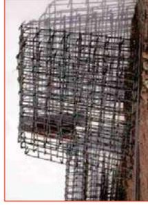
Habilitado de acero de zapatas de 20 cm de espesor
