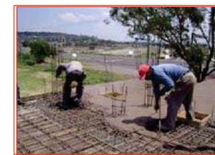
Colado de losa meciza de de 12 cm de espesor
