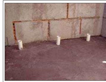
Ranurado para tubo de 1/2" por muro
