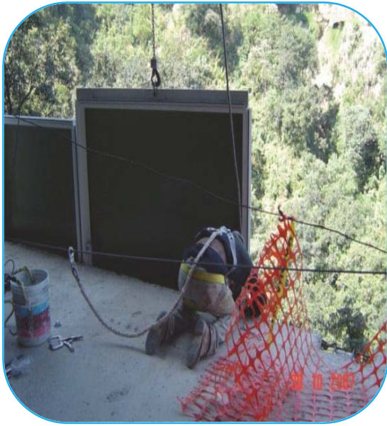
Foto 134 fijación y nivelación de modulo
