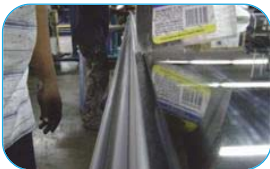
Foto No. 72 Aplicación de soft backer rod
