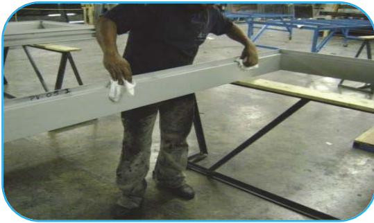
Foto No. 66 Limpieza del vano
