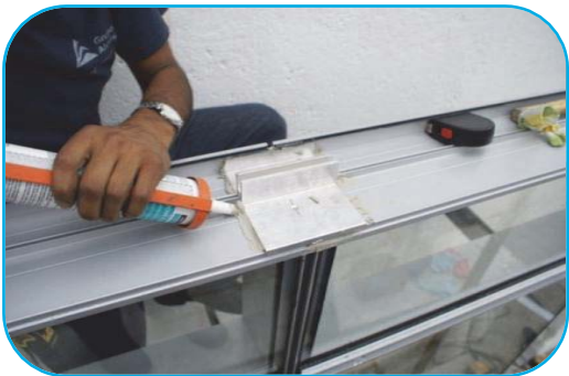
Foto 148 sello en juntas críticas.
