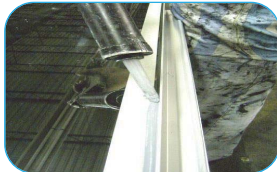
Foto No. 71 Aplicación del silicon.
