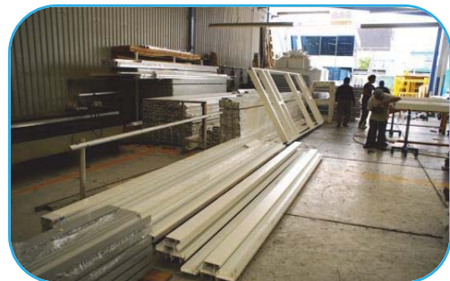
Foto No. 81 Almacén de obra.
