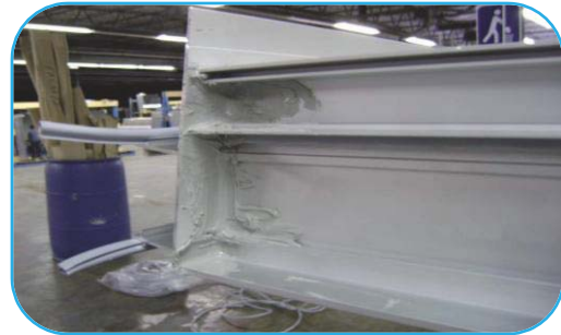
Foto No. 64 silicón en uniones
