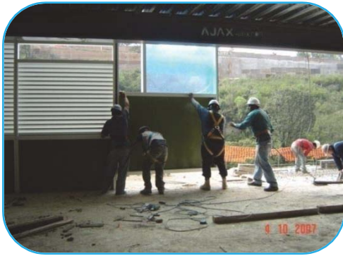
Foto No. 40 Instalación machimbrado
