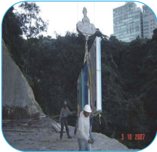
Foto 126 preparación para elevación de módulo
