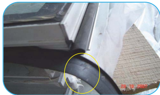
Foto 110 Revisión de Cortes en lengüetas
