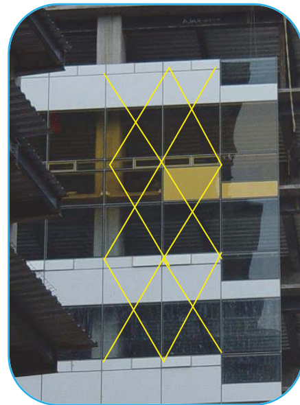
Foto No. 39 Módulos Instalados.
