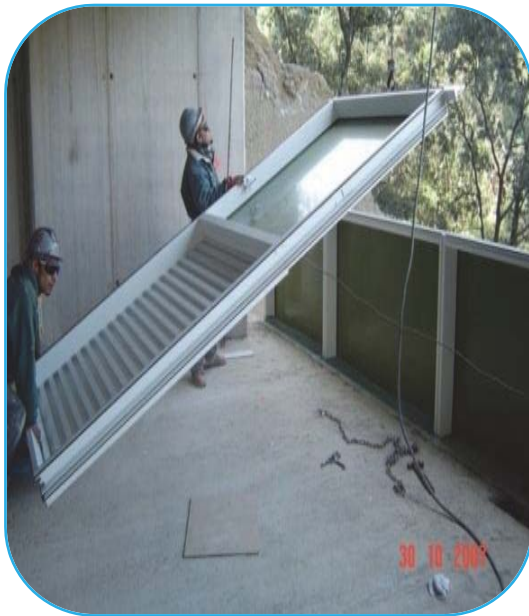
Foto 132 Elevación de modulo
