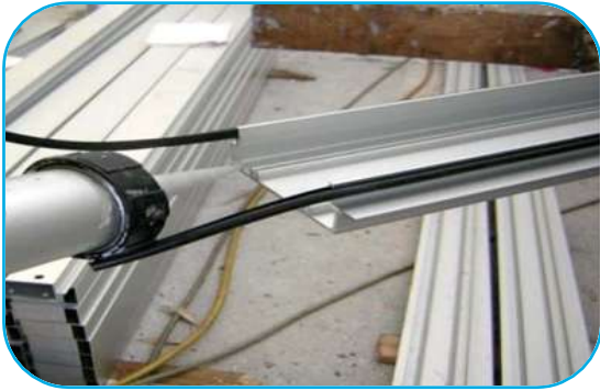
Foto No. 59 Aplicación de silicón para recibir vinilos
