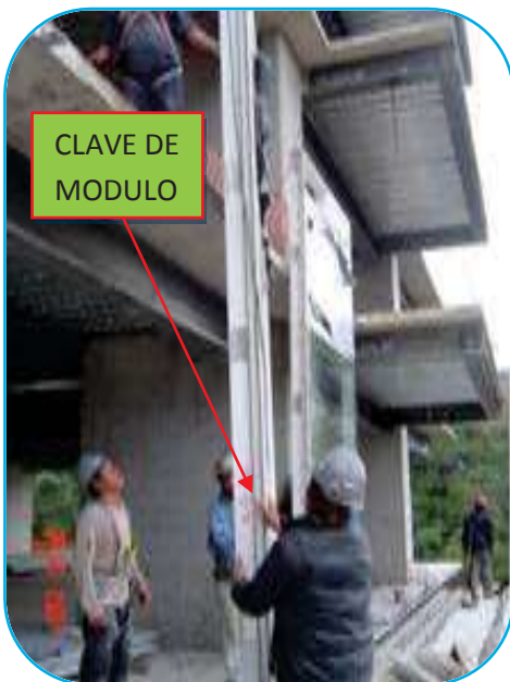
Foto No. 94 Modulo (hembra) para ensamblar
