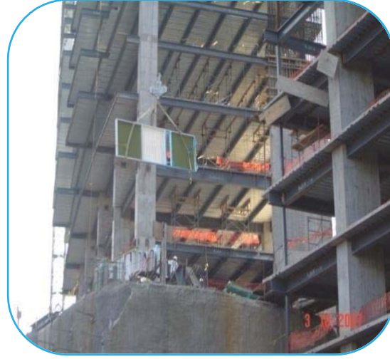
Foto 127 Elevación del material prefabricado
