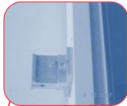
Foto 105 Ancla de aluminio tipo Allen con tornillo 3/8" sujetado al poste del perfil.
