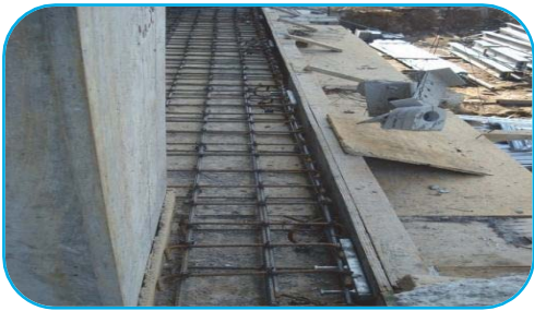
Foto 156 anclaje previo al colado.
