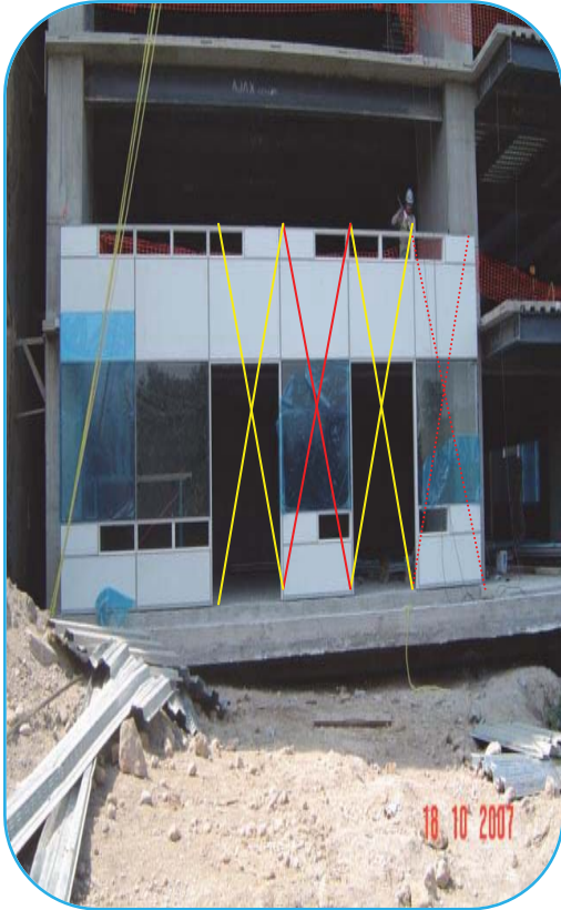
Foto No. 96 Colocación de cada módulo según su clave.
