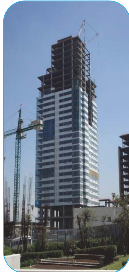
Foto 114 Torre "A" Avance de instalación
