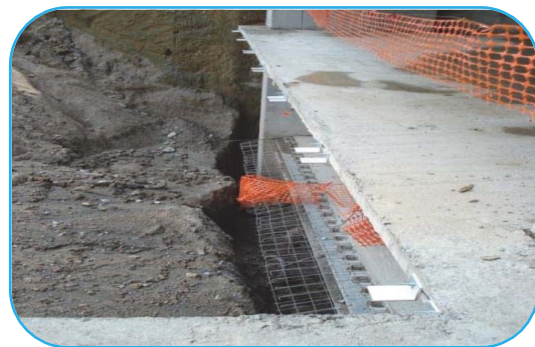
Foto No. 37 Ángulos instalados sobre ancla
