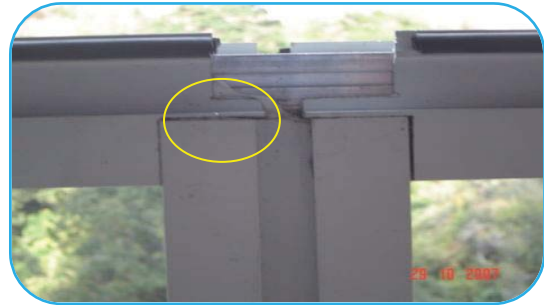
Foto 108 Cuidar corte y alineamiento
