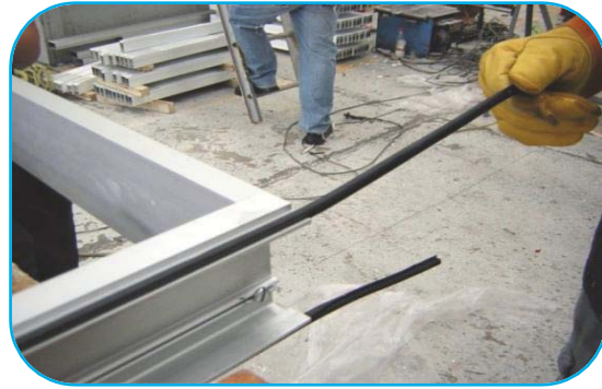
Foto No. 60 colocación de vinilos
