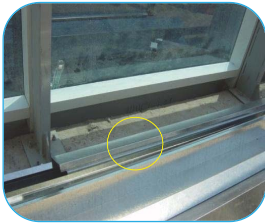
Foto 144 Acabado con Panel.
