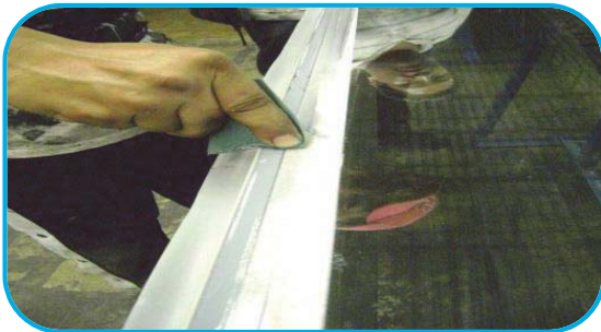
Foto No. 74 fijación de sellador con cuña
