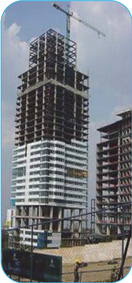
Foto 113 Torre "A" Avance de instalación
