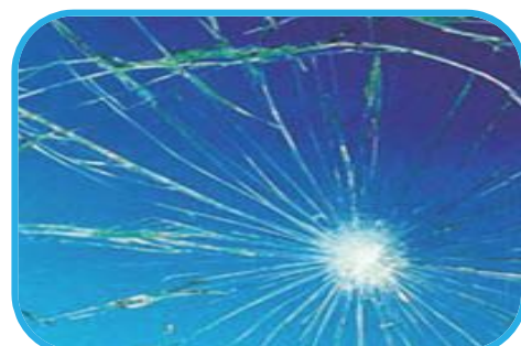
Foto No.14 rotura de vidrio laminado
