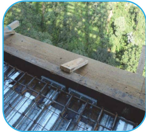
Foto 29. Anclaje en obra.
