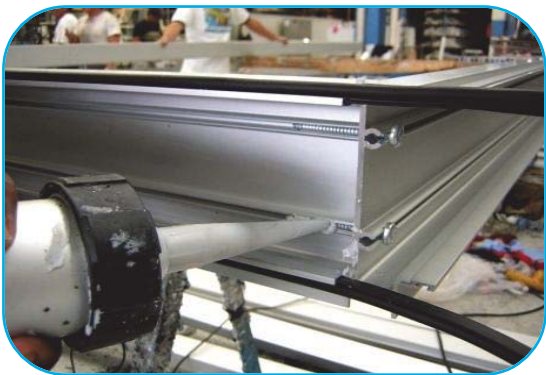
Foto No. 61 Aplicación de sello en pijas
