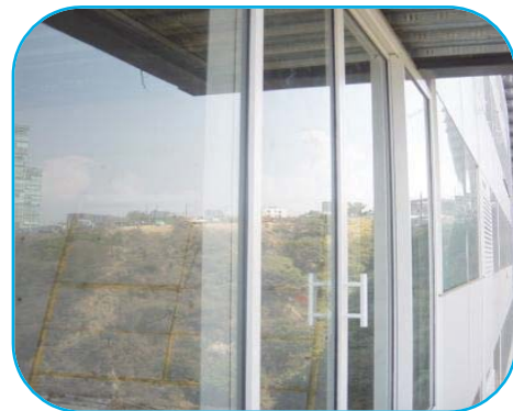
Foto No. 47 ventanal corredizo
