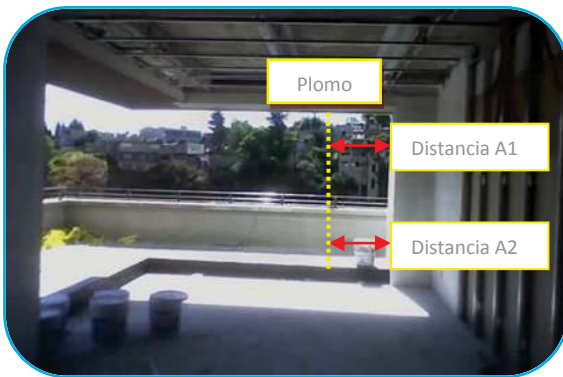
Foto No. 46 Revisión de plomos
