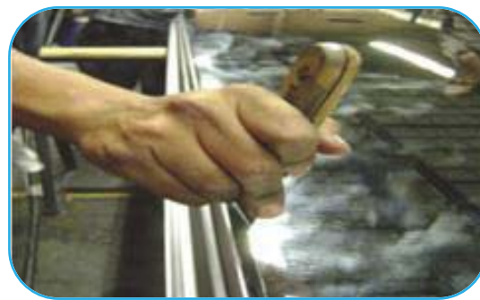
Foto No. 73 Empuje de pala para backer
