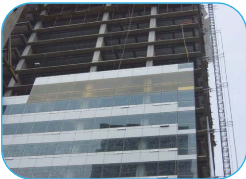
Foto No. 42 Instalación de módulos tipo
