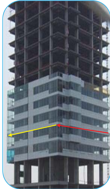
Foto No. 97 Secuencia de colocación
