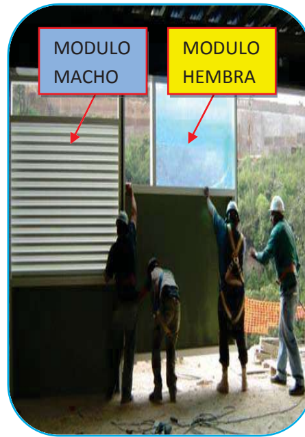
Foto No. 95 sistema machimbrado.
