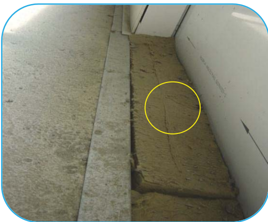
Foto 140 cama de lamina con fibra contrafuego.
