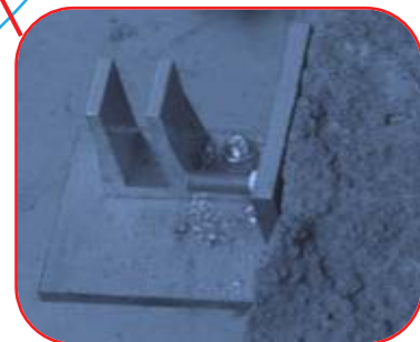
Foto 103 colocación del ancla con el ángulo de aluminio 41/2" x 3/8
