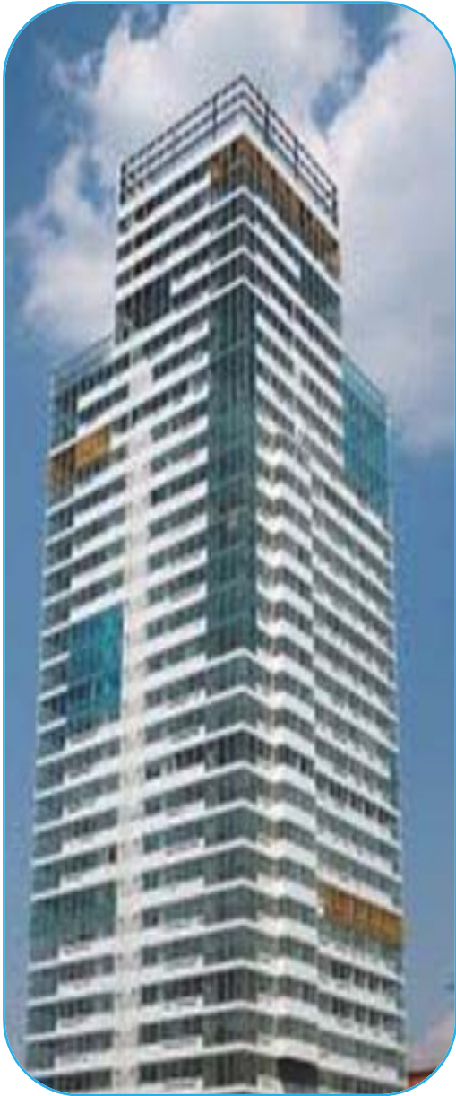
Foto 136 Torre “A” instalación terminada
