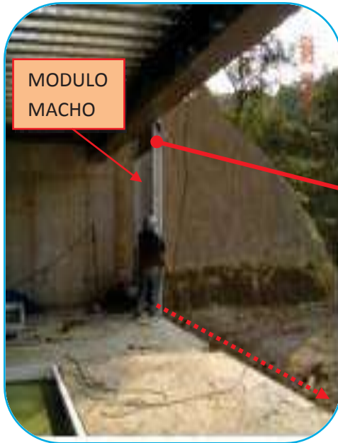
Foto No. 92 instalación del modulo "macho" para continuar la colocación serial.
