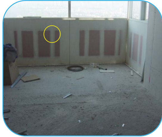
Foto 143 Acabado aparente (tablaroca).
