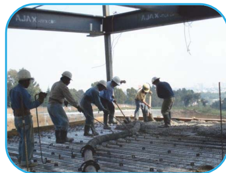
Foto No. 31 Colado de losas
