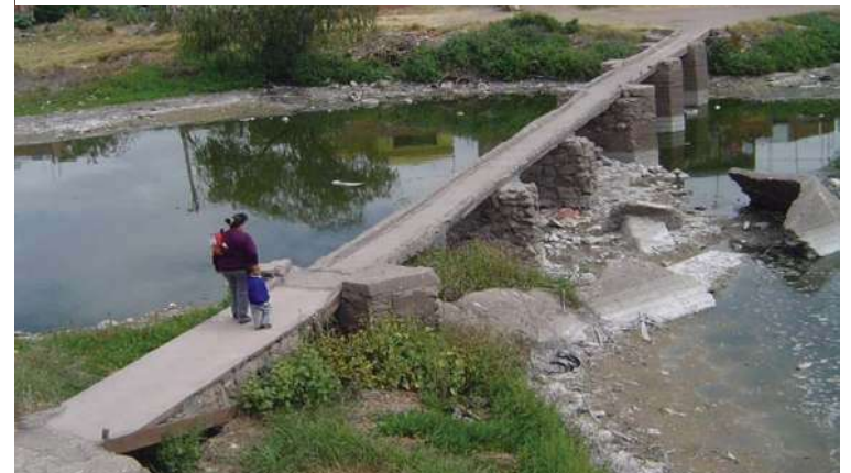
FIG.33. "puente peatonal la placa". ANDRE AGUILAR.
