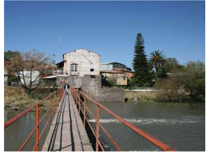
FIG.35. en esta imagen también como la gente cruza por las compuertas, aunque podríamos decir que esta parte es más segura que la otra ya que cuenta con un barandal el cual le da seguridad y protege a las personas que utilizan este camino. Pero aun así se pudo percibir que este barandal ya está deteriorado y en cualquier momento este puede caer y dejará de ser un cruce más o menos seguro. Salvador García. Julio 2009
