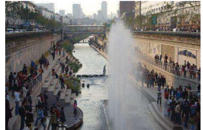
FIG.5. cauce del río actualmente. www.google.com.mx
