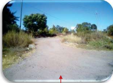
Imagen 59. Acceso principal del proyecto con un ancho promedio vial de 7 m, el predio está situado a 25 metros de distancia del centro de la carretera al vértice oriente del terreno, por lo que se encuentra fuera del derecho de vía de la carretera. FLORES S. 2010.
