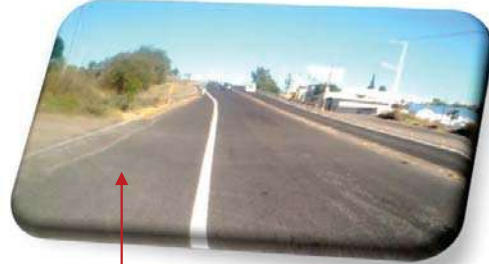
Imagen 60. Incorporación de las carreteras provenientes del entronque al predio, donde se localiza una gasa de desaceleración existente prevista para el proyecto Melchor Ocampo. FLORES. S. 2010.
