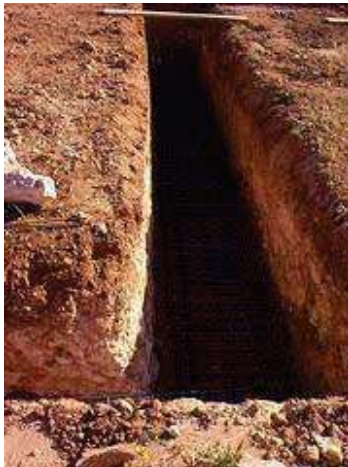
Imagen 57.- Armado de una zapata corrida.
