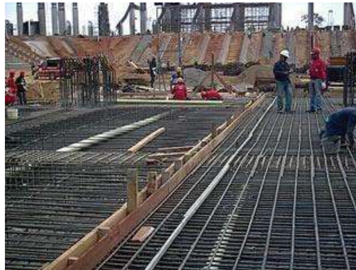
Imagen 60.- Armado de una losa maciza.
