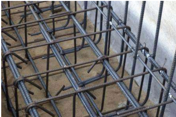
Imagen 55.- Acero que se utilizara para la construcción.
