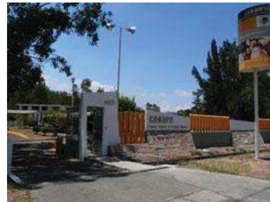
Imagen 7.- Instalaciones de CONAFE en Michoacán.
