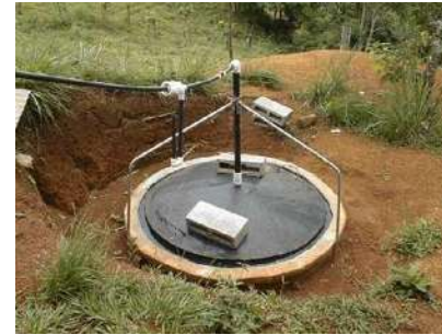
Fig. 74_Instalación de Biodigestor. www.ruralcostarica.com/biodigestor. 22/01/11.
