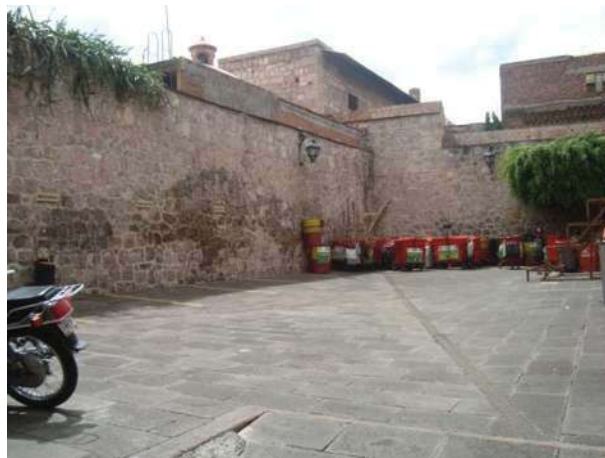
Foto: 14: Estacionamiento Interno
