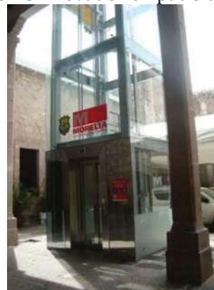
Foto 13: Elevador en patio trasero
