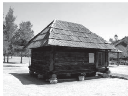
Fig. 50.- Ejemplo cubierta a cuatro aguas. www.purhépechas.com
