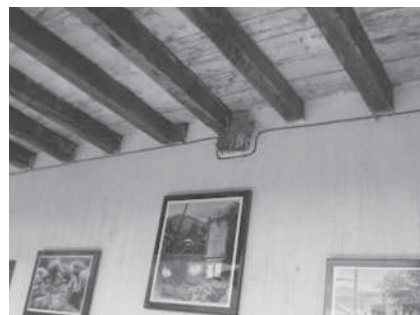
Fig. 48.- Detalle de traslape en las vigas de madera Foto: Alfonso Álvarez Sandoval
