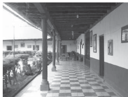
Fig. 49.- Ejemplo de colocación sistematizada de columnas. Foto: Alfonso Álvarez Sandoval
