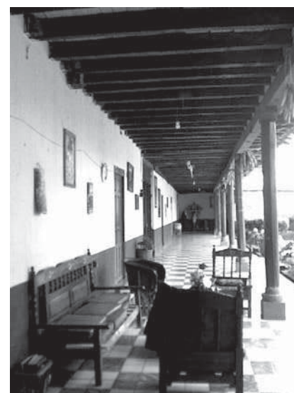
Fig. 8.-Detalle de la colocación sistematizada de vigas y columnas. Foto: Alfonso Álvarez Sandoval
