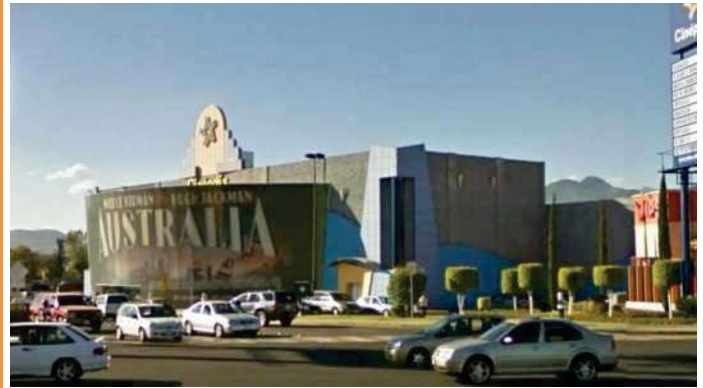
Imagen 3: Fachada principal de Cinépolis la Huerta/ fuente: GoogleEarth, 25/05/2011.
