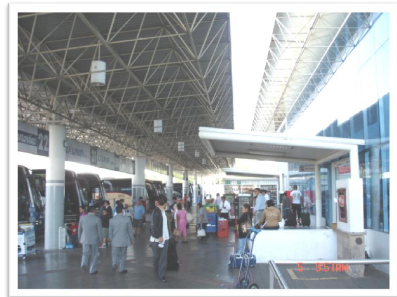
ILUSTRACIÓN 34. ZONA DE ANDENES. SALA A DE LA TAM. FOTO. JBMS.
