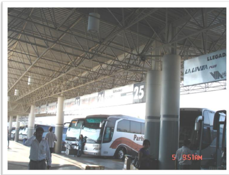
ILUSTRACIÓN 33. ZONA DE ANDENES. SALA A DE LA TAM. FOTO. JBMS.
