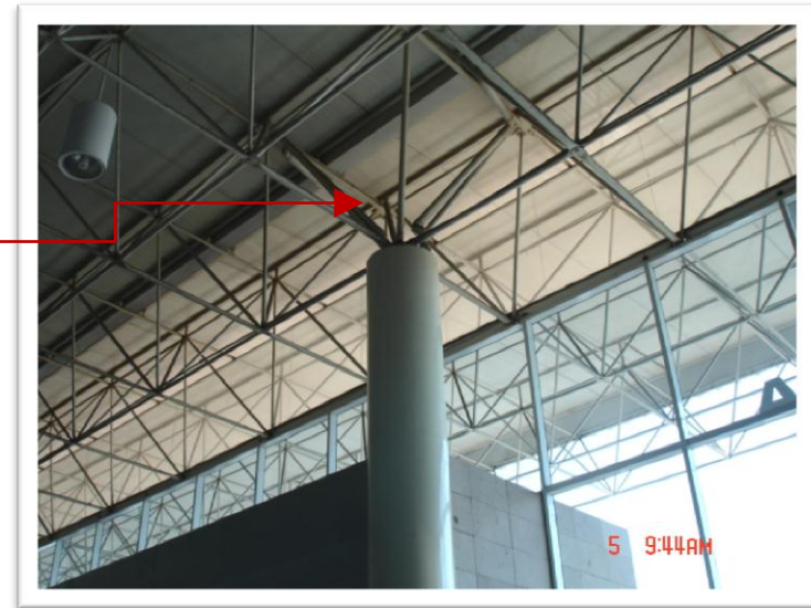
ILUSTRACIÓN 36. ENSAMBLE DE COLUMNA CON LA CUBIERTA SUPERIOR .SALA A DE LA TAM. FOTO. JBMS.
