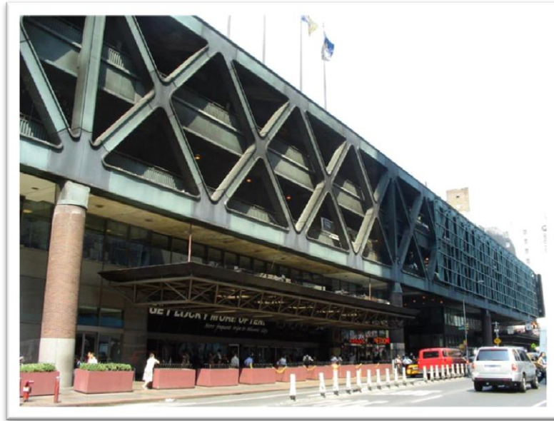
ILUSTRACIÓN 26. FACHADA LATERAL CENTRAL PORT AUTHORITYNY.WWW.PORTAUTHORITY.ORG
