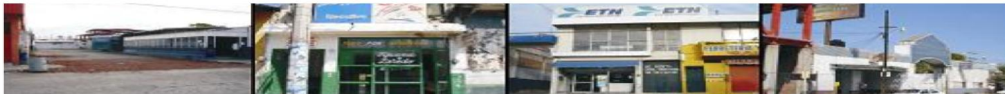
ILUSTRACIÓN 5. FACHADAS DE DISTINTAS CENTRALES DISPERSAS EN LA CIUDAD. FOTO JMS
