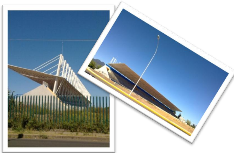
ILUSTRACIÓN 81. GRADAS DEL CANCHA DEPORTIVA DE LA UNIVERSIDAD MICHOACANA DE SAN NICOLAS DE HIDALGO, MORELIA. FOTO. JBMS
