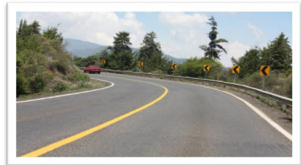
ILUSTRACIÓN 1 CARRETERA FEDERAL APATZINGA-CUATRO CAMINOS.
