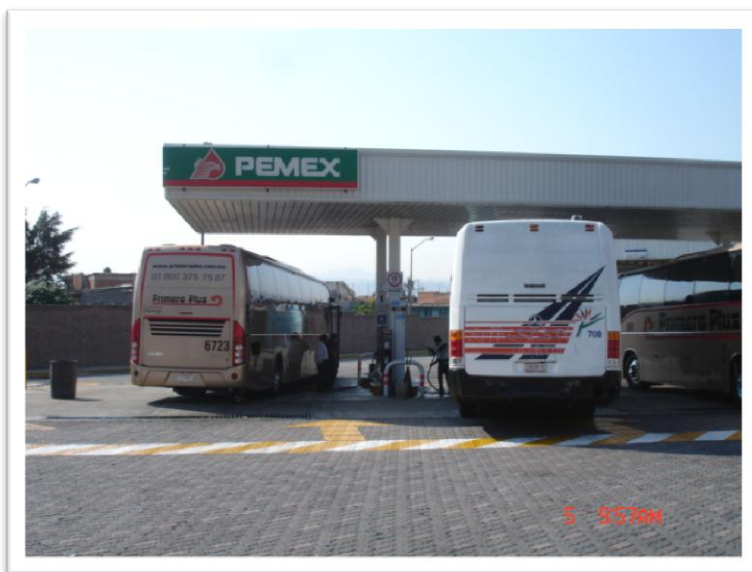
ILUSTRACIÓN 40. ZONA PUBLICA INTERIOR (GASOLINERA PARA AUTOBUSES) FOTO JBMS.
