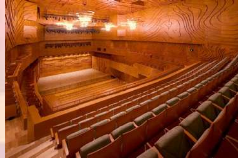
Fotografía 02: interior del teatro donde se aprecia el acabado para tener una buena acústica.
