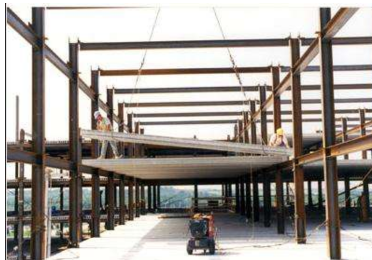
Ilustración 3 Estructura en acero. Fuente: http://www.itisa.mx (marzo 2011).
