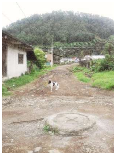
Ilustración 16 Servicio de alcantarillado. Fuente: fotografía tomada por SSD. Septiembre 2010.
