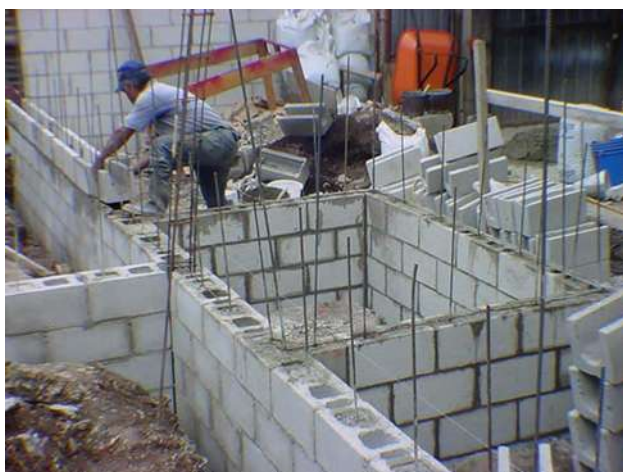
Ilustración 9 Colocación del muro de block hueco de concreto. Fuente: Google (marzo 2011).
