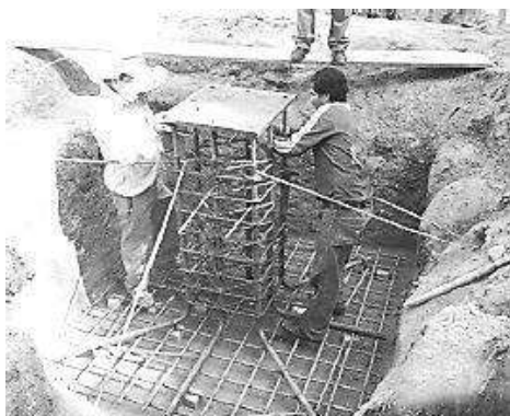
Ilustración 15 Colocación de la placa para la columna de acero. Fuente: Google (marzo 2011).
