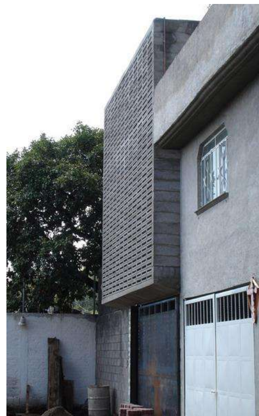
Ilustración 10 Muro de block hueco de concreto utilizado como fachada. Fuente: Google (marzo 2011).
