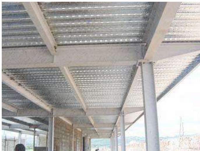
Ilustración 4 Instalación de losacero. Fuente: Google. (Marzo 2011)
