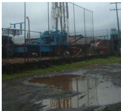
Ilustración 26 Calle Curitziran sin pavimentación y sin construcción de la banqueta. Fuente: fotografía tomada por SSD. Septiembre 2010.
