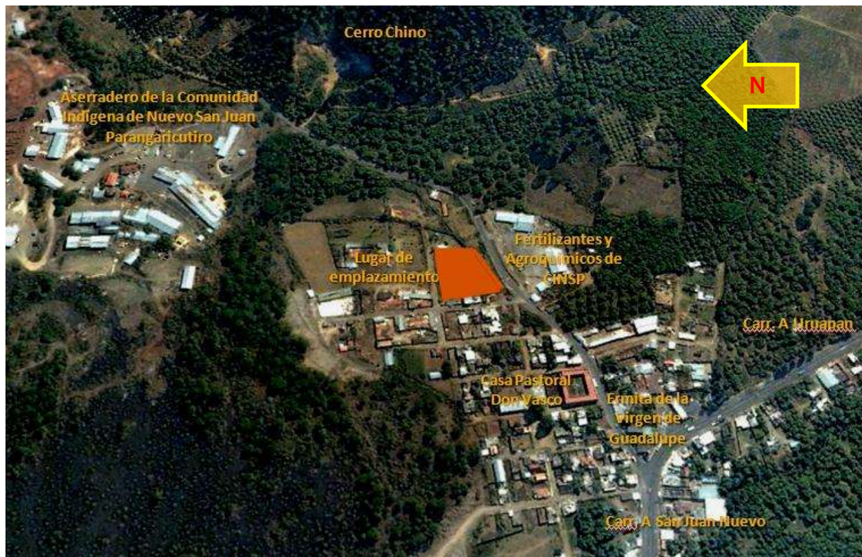
Ilustración 6 Vista aérea de la localización del predio en la colonia Tzindio, fraccionamiento Félix Ireta, Nuevo San Juan Parangaricutiro. Fuente: Google Earth. 2010
