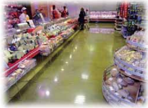
Imagen 12: Ejemplo de concreto pulido fino utilizado en el proyecto.
