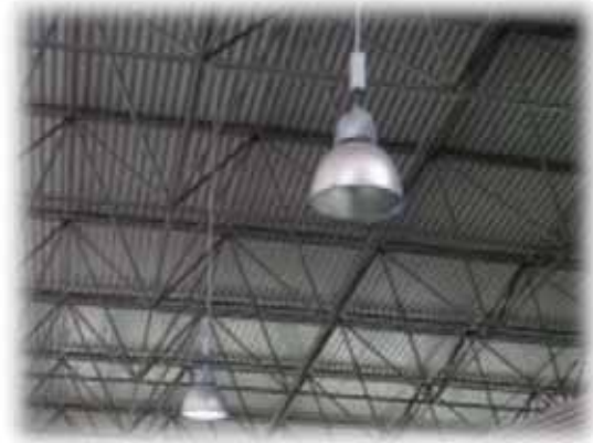
Imagen 3: Ejemplo de Cubierta de estructura tridimensional con lámina metálica acanalada.
