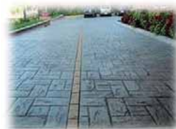
Imagen 7 y 8: Ejemplos de Loseta de barro y concreto estampado utilizados en pisos exteriores del mercado.
