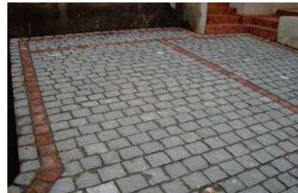
Imagen 49. Pavimentado por adoquín
