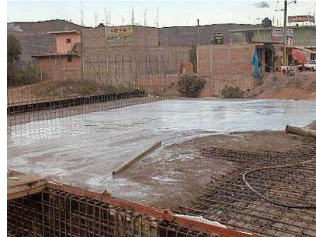
Imagen 63. El acero de refuerzo va ahogado en la losa
