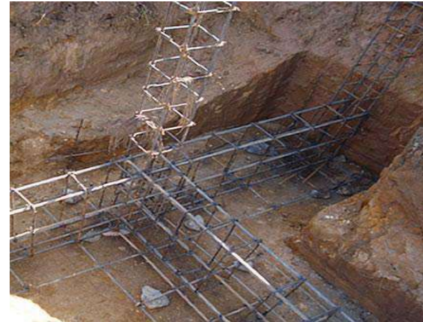
Imagen 31. Acero de refuerzo
