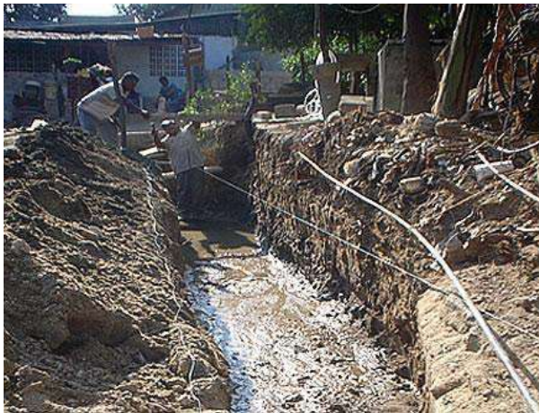
Imagen 30. Ceba de cimentación
