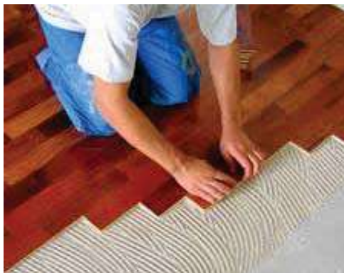
Imagen 41. Instalación con base de adhesivo
