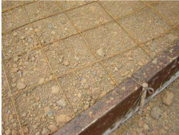
Imagen 53. Malla electrosoldada y cimbra de frontera
