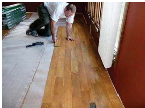
Imagen 40. Experto instalando piezas sobre el aislante
