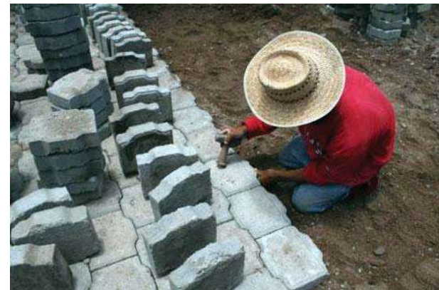
Imagen 51. Emplazamiento y nivelación de piezas
