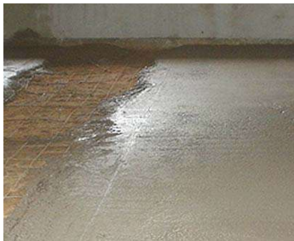
Imagen 34. Colado de concreto para firme
