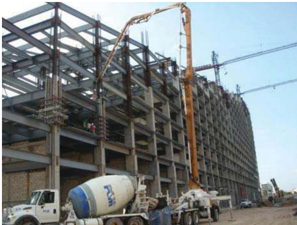
Imagen 57. Ensamble de miembros metálicos en el complejo "Andares", Guadalajara
