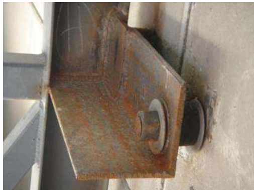
Imagen 59. Unión de placas metálicas con piezas atornillables
