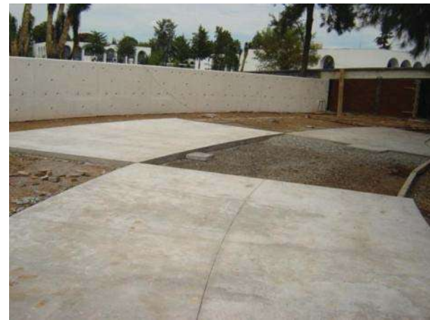
Imagen 54. Colado alternado de placas de concreto a manera de ajedrez
