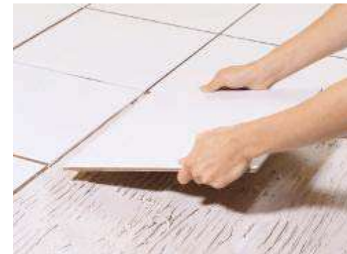
Imagen 37. La colocación de la loseta es completamente manual
