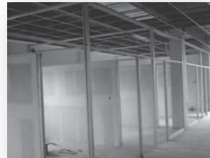
Fig. 26 Separación de áreas por medio de muros de tablaroca
