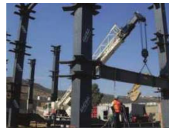
Fig.29 Estructura de acero
