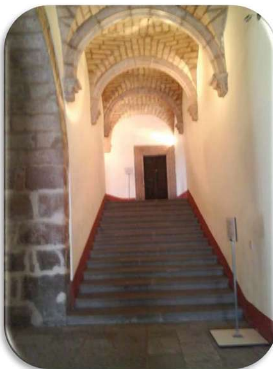
Imagen 50.- Escaleras para acceder a la planta alta de la Casa de la Cultura/foto tomada por autor/26-05-2011.
