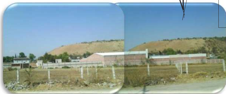
Imagen 38.- Fachada No. 4/Foto tomada por autor/30-05-2011.
