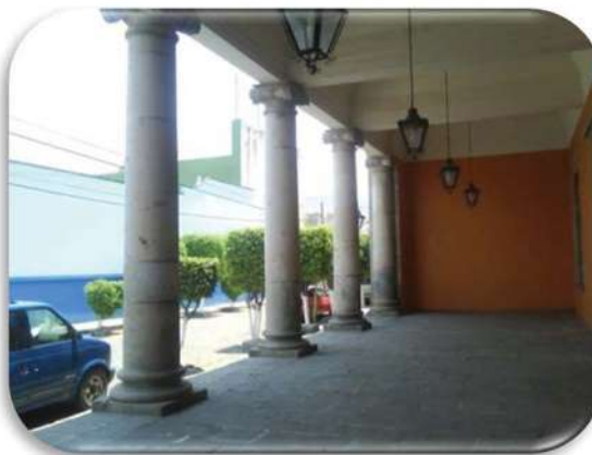
Imagen 15.- Pórtico de acceso del Teatro Hidalgo de Zinapécuaro Michoacán.
