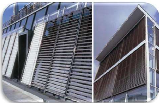
Imagen 64.- Persianas de aluminio especiales para protección solar.
