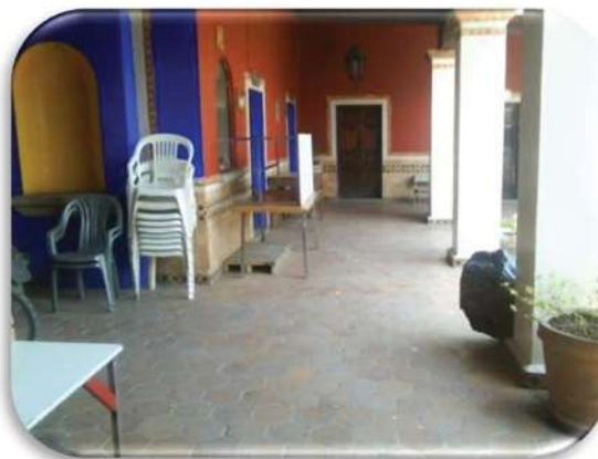
Imagen 1.- La falta de una bodega provoca que el mobiliario lo ubiquen en los pasillos del inmueble.
