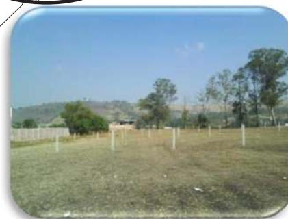
Imagen 39.- Fachada No. 2/Foto tomada por autor/30-05-2011.
