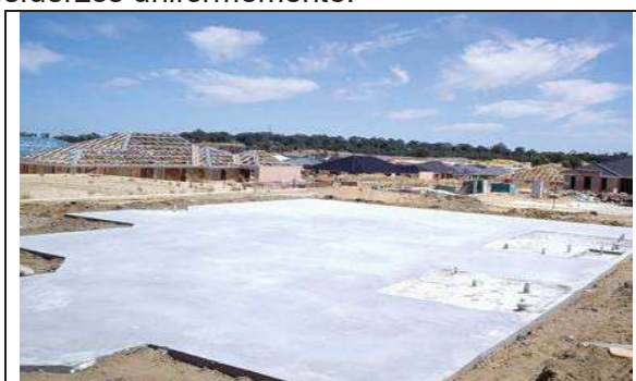
Fig.57 Ejemplo de una losa de cimentación, http://es.wikipedia.org/wiki/Losa_de_cimentaci%C3%B3n
