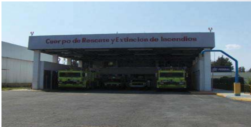
ZONA DE RESCATE AEROPUERTO DE MORELIA, aap. Abril 2009
