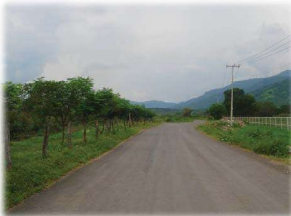
Imagen No. 35. Avenida a un costado del predio. Servicio eléctrico. V. E. MARTÍNEZ S.
