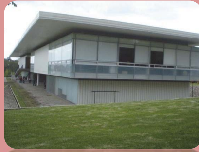
Imagen No. 40. Fachada de cristal y doble losa. V. E. MARTÍNEZ S.
